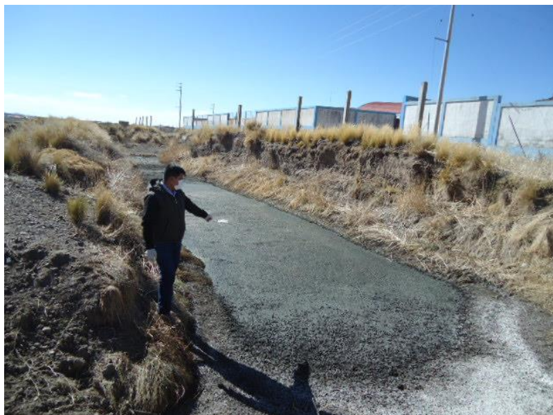
Foto 6. Vertimiento de aguas del camal contaminado al exterior del camal municipal - Ilave.
