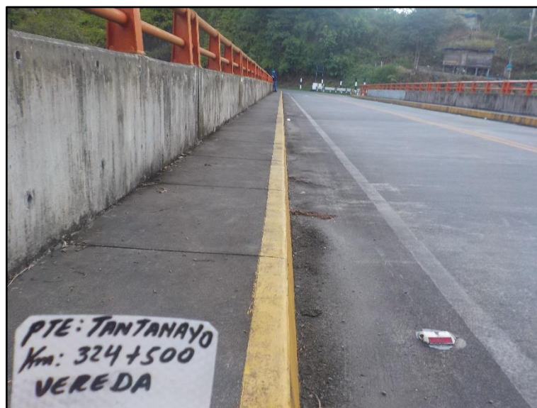
Figura 25. Inspección visual vereda - puente Tantamayo.
