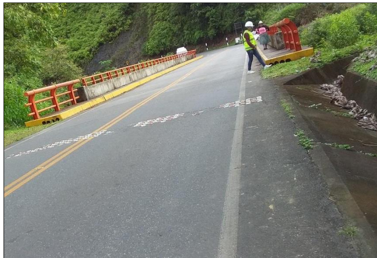
Figura 21. Recorrido 2 en zigzag en el puente Tantamayo.
