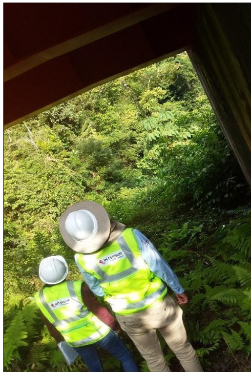
Figura 23. Recorrido por la parte inferior para inspección de viga, puente Tantamayo.
