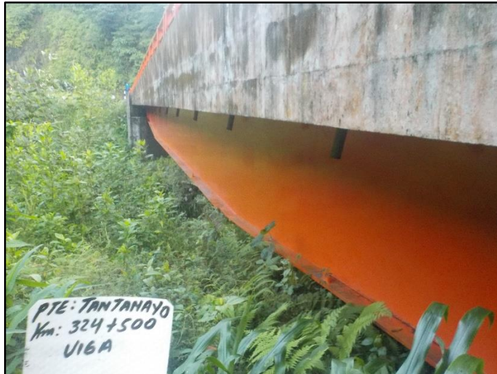
Figura 22. Recorrido de V1 y V2, puente Tantamayo.
