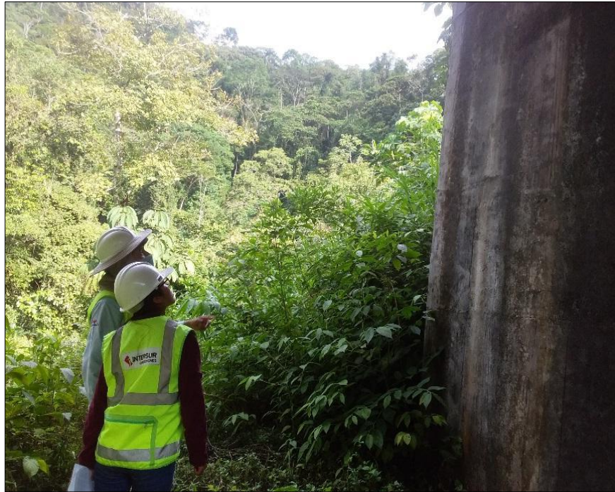
Figura 18. Recorrido perimetral por el estibo E-1, puente Tantamayo.
