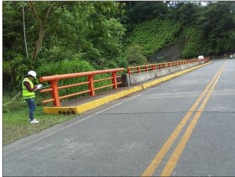
Figura 20. Recorrido 1 en zigzag en el puente Tantamayo.
