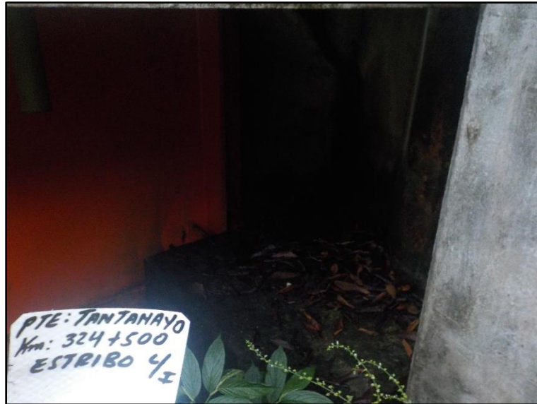
Figura 24. Inspección visual estibo - puente Tantamayo.
