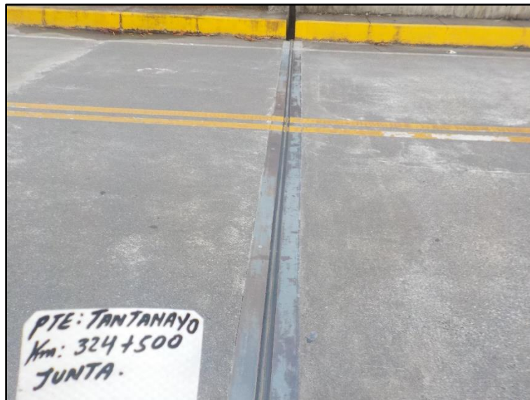
Figura 26. Recorrido, inspección junta de dilatación - puente Tantamayo.
