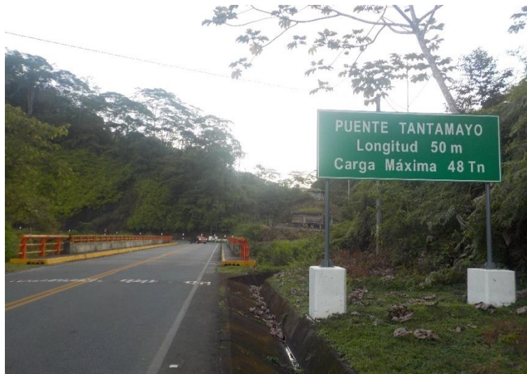
Figura 16. Ej. Identificación de puente - Tantamayo.
