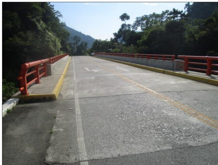
Figura 17. Acceso a puente (Tantamayo).
