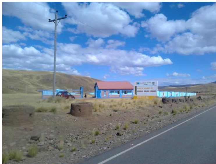
Imagen 7. Planta de tratamiento de residuos sólidos del distrito de Ajoyani.
