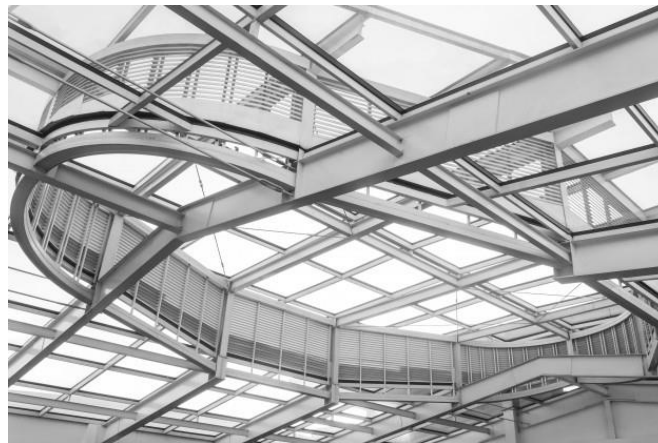
Figura 58: Estructuras Metálicas en Coberturas.
