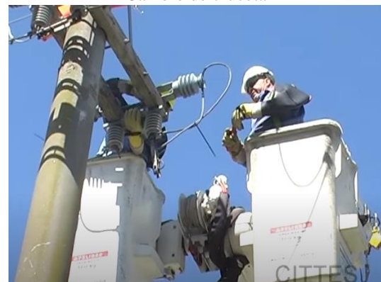
Retemplado de seccionador
