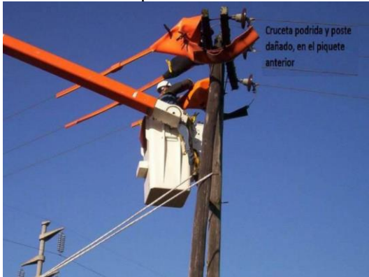
Cambio y/o instalación de poste
