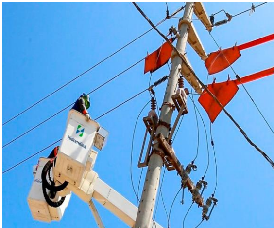
Figura 5. Mantenimiento de red aérea con tensión
