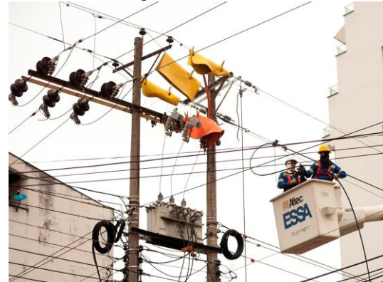
Cambio de transformador
