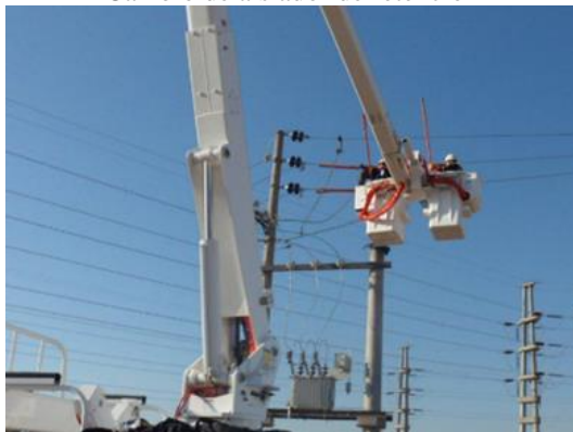
Retemplado de conductor
