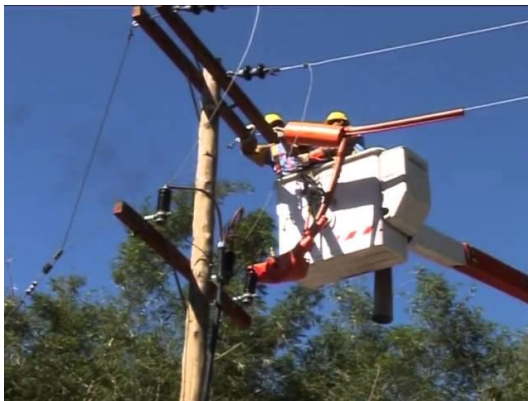
Cambio de aislador de retención
