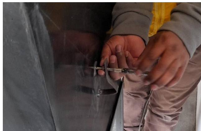
Figura N° 29: Montaje de la termocupla
