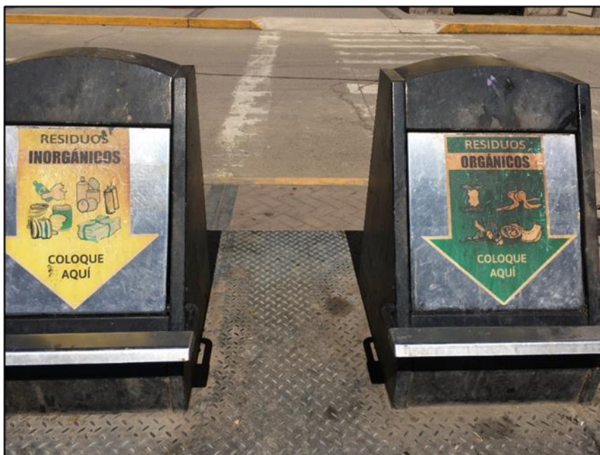
Figura 65. Contenedores subterráneos Parque de las Aguas
