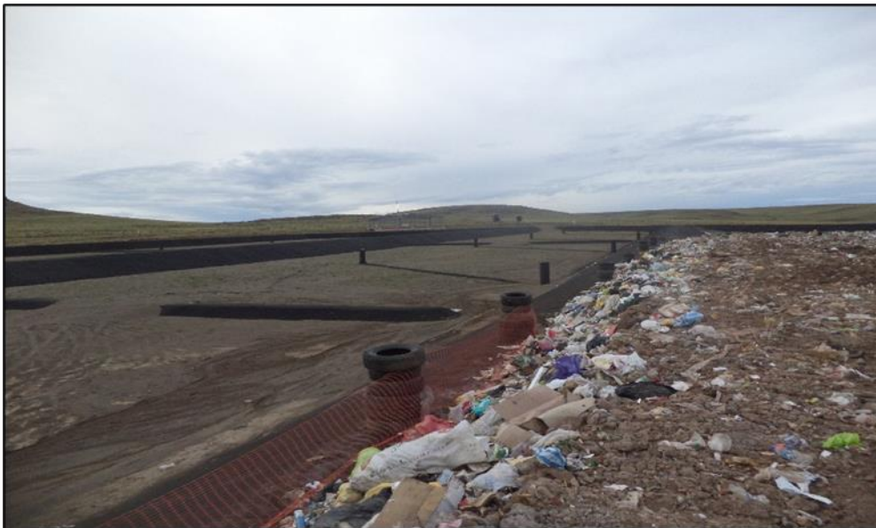
Figura 70. Llenado de residuos sólidos de la primera celda
