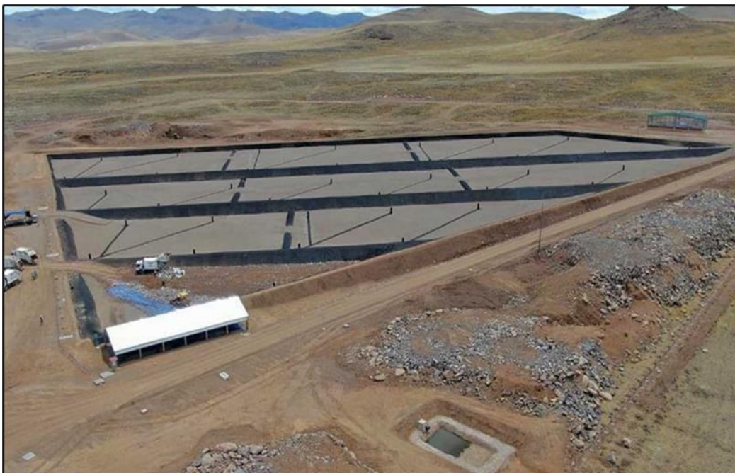
Figura 67. 4 Celdas transitorias del Relleno Sanitario de Itapalluni
