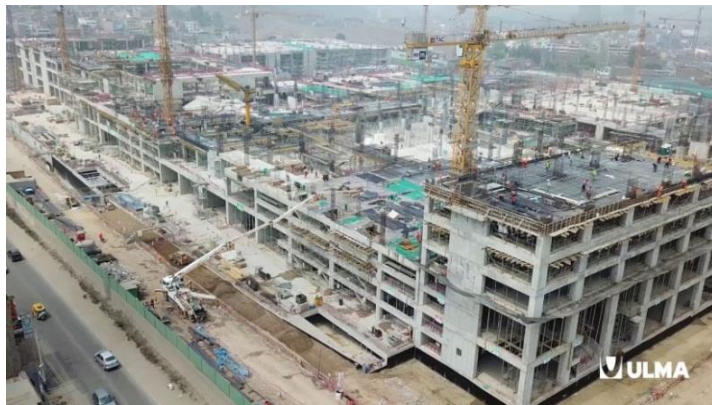
Figura 30: Trabajos realizados por ULMA construction en encofrados
