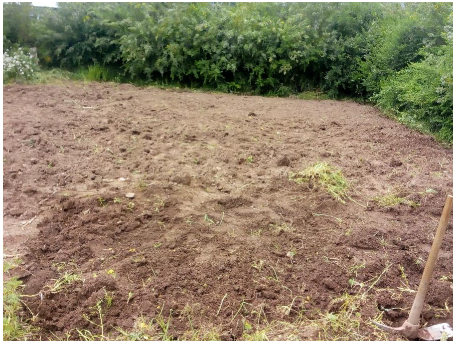
Figura 9. Roturado de terreno.
