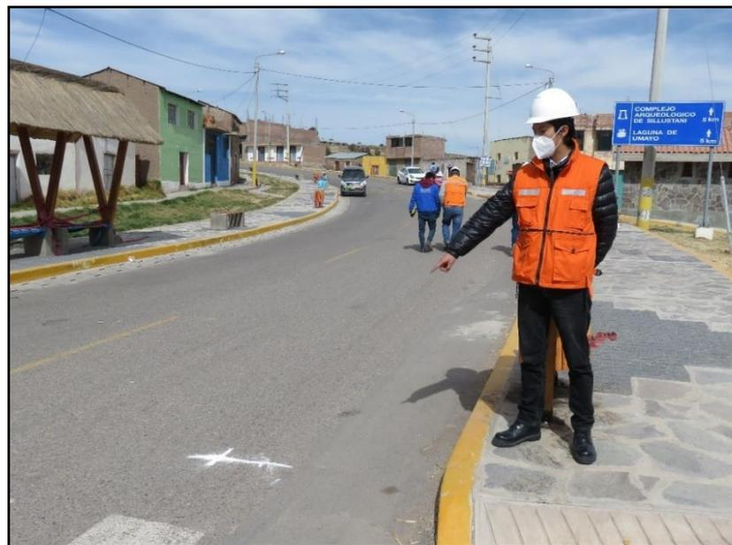
**Figura 22:** Marca de los puntos de ensayo
