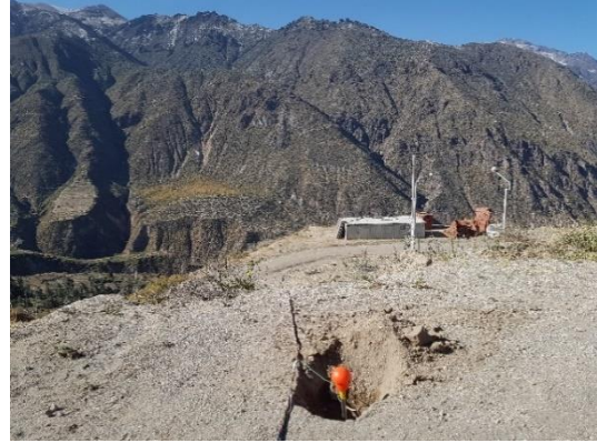
Plantado de electrodos, vista NE Fuente, Autor 2020
