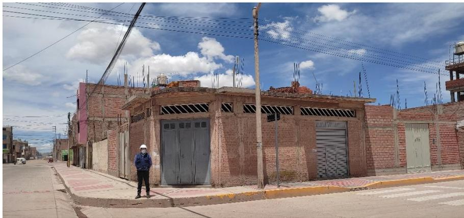
d) *Sistema estructural híbrido con unidades de albañilería artesanal de 2 niveles a más (SEHUAA)*. Según la Figura 17, son viviendas cuyo sistema estructural está compuesto por albañilería confinada y sistema de pórticos de concreto armado, la unidad de albañilería usada en sus muros portantes es de origen artesanal, para esta tipología los primeros niveles cuentan con unidades artesanales y los niveles superiores industriales se considerará esta tipología.
