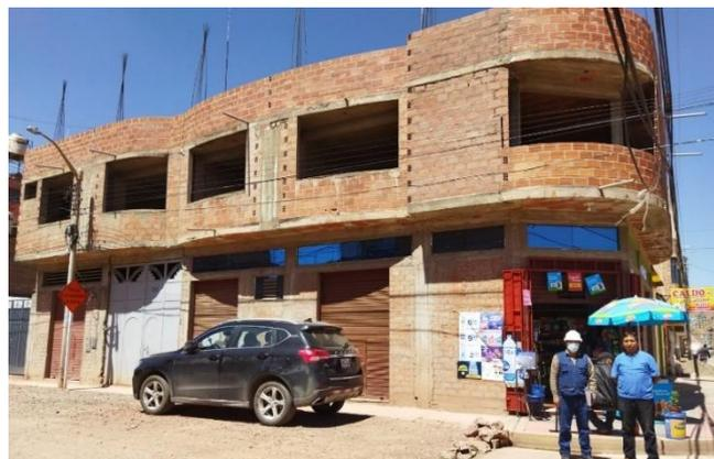
c) *Sistema estructural híbrido con unidades de albañilería artesanal de 1 nivel (SEHUAA1)*. Como se puede observar en la Figura 16, son viviendas cuyo sistema estructural está compuesto por albañilería confinada y sistema de pórticos de concreto armado, la unidad de albañilería usada en sus muros portantes es de origen artesanal, esta tipología solo se considera a viviendas de un nivel cuya unidad de albañilería es la sólida artesanal o más conocida como King Kong artesanal.
