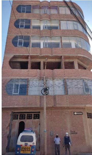
b) *Sistema estructural híbrido con unidades de albañilería industrial de 1 a 3 niveles (SEHUI4).* Según la Figura 15 se puede observar que son viviendas cuyo sistema estructural está compuesto por albañilería confinada y sistema de pórticos de concreto armado, cuya elevación va de 1 a 3 pisos, para este tipo deberá de contar con unidades de albañilería industrial en todos sus muros portantes.
