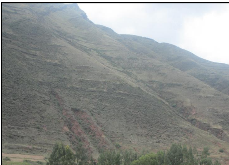
Figura 8. Cárcavas en el sector de Yanamanchi. Parte media de la microcuenca. Margen izquierda del río Lucre. En la siguiente Tabla, se realiza la comparación de los resultados obtenidos con los resultados de otros autores:
