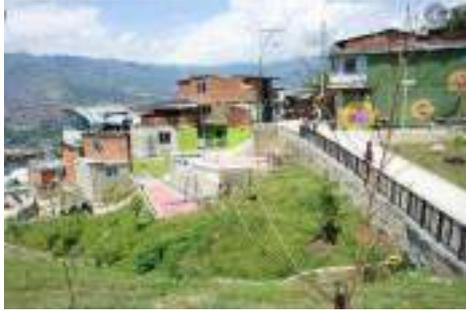
El sistema constructivo esta basado en muros de contención de concreto para afianzar el terreno de la quebrada y pendientes algo pronunciadas con respecto del accidentado estado topográfico
