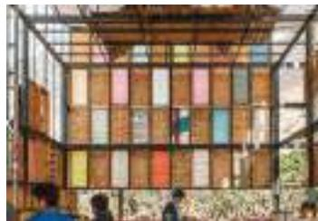
Esteras y calaminas para la fachada y cubierta de toda la estructura metálica
