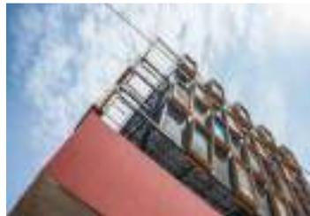
Utilización de marcos de madera para la elaboración de paneles con sistema de montaje que permite armar y desarmar para variar el diseño de toda la fachada.
