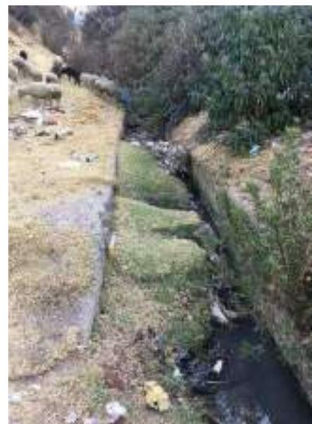
Figura 60: Collage de Fotografías del emplazamiento, muestra la situación precaria del canal de concreto existente.
