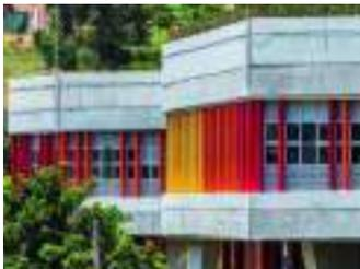
Utilización de laminas metálicas para la fabricación de los paneles tipo persiana que funciona como envoltente de la estructura. De igual modo se utilizo barras metalicas para el uso de cercas por todo el proyecto.
