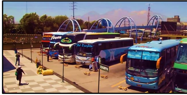
Figura 2.28: Andenes y patio de maniobras del terminal de Arequipa.
