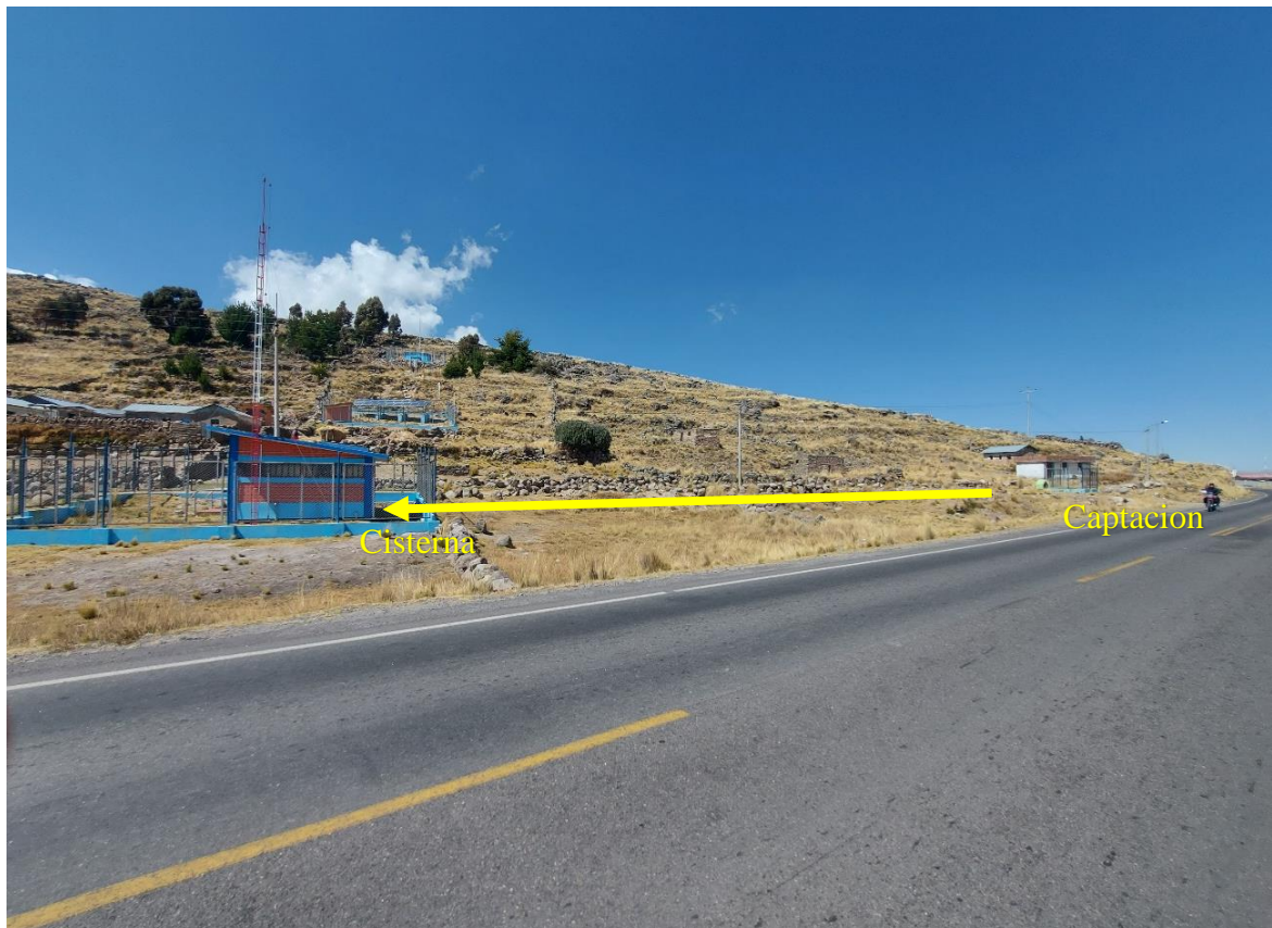
Figura 8. Sistema de captación y cisterna de 30 m 3
