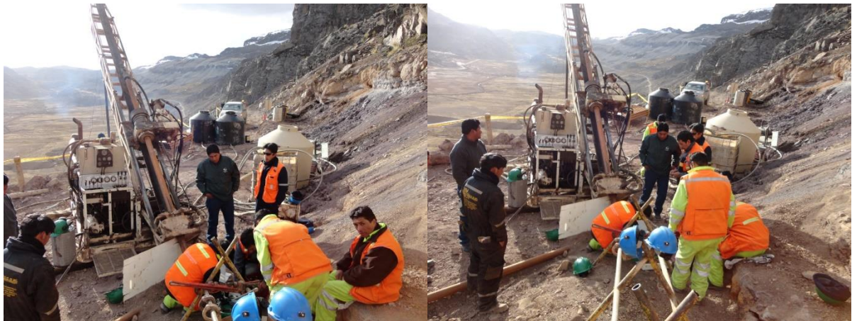
Punto de Perforación
