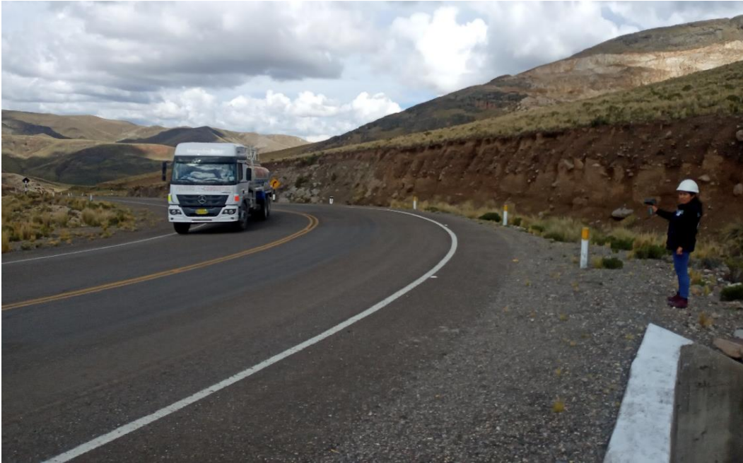
Foto N°5: Medición de velocidades en curva N°1
