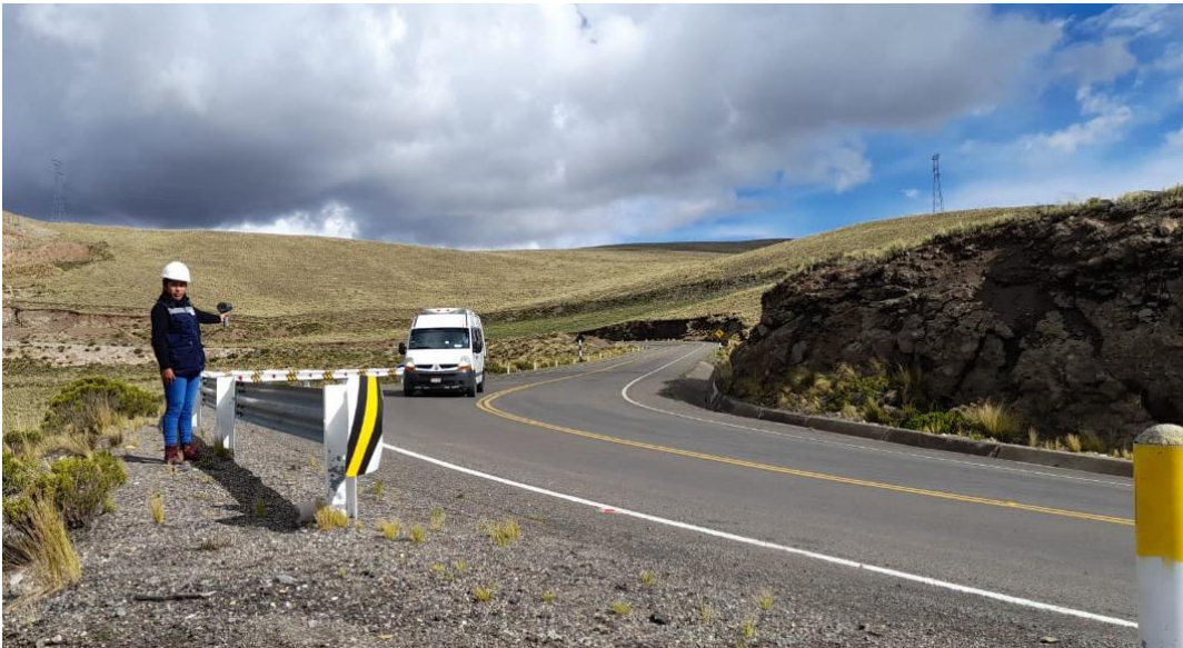
Foto N°8: Medición de velocidad en curva N°5
