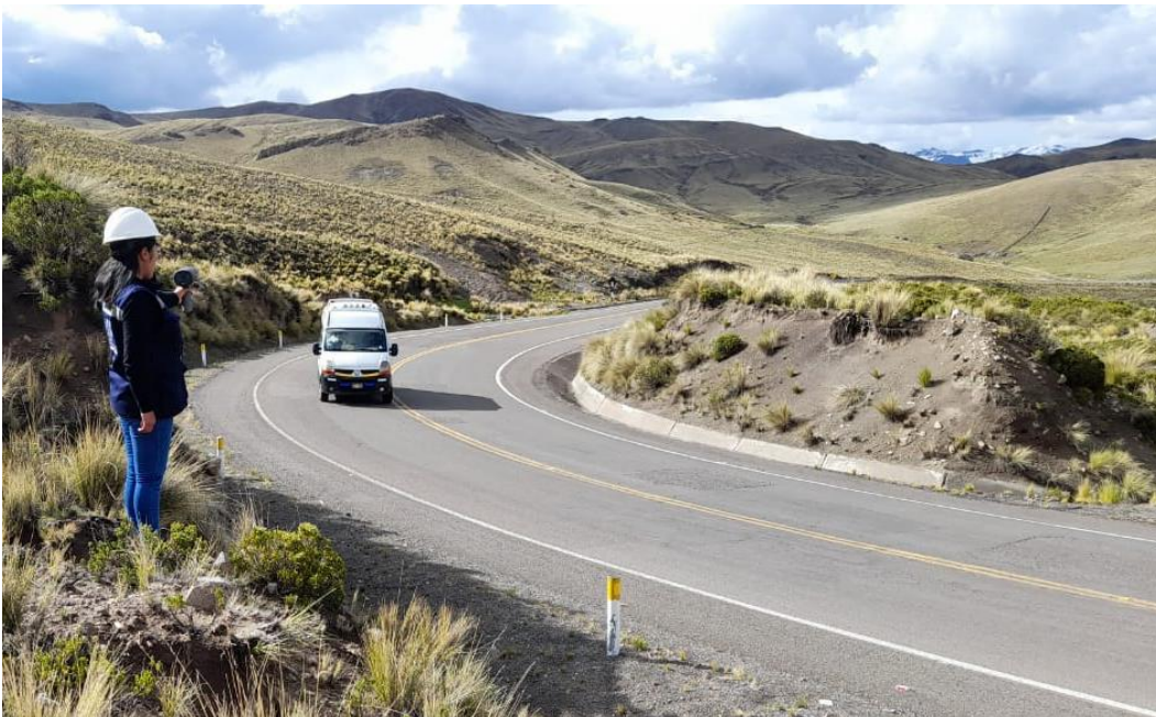
Foto N°6: Medición de velocidad en curva N°4
