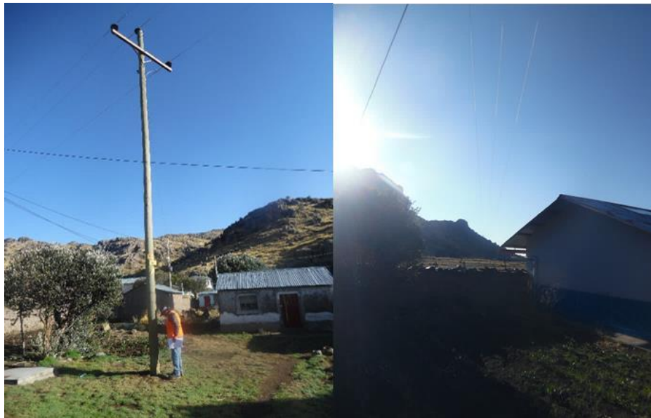
Figura N° 3.12: Poste de Madera ubicado en vivienda Elaboración Propia.
