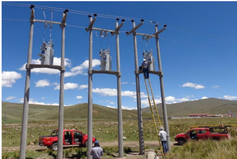
Figura N° 3.32: Regulador de Tension Santa Lucia. Elaboración Propia.
