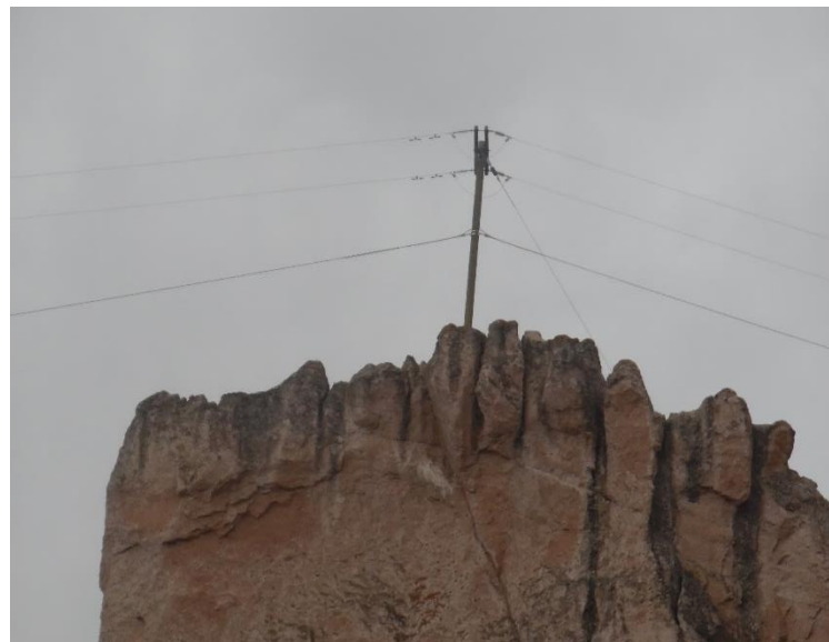
Figura N° 3.13: Poste de Madera ubicado la punta cerro. Elaboración Propia
