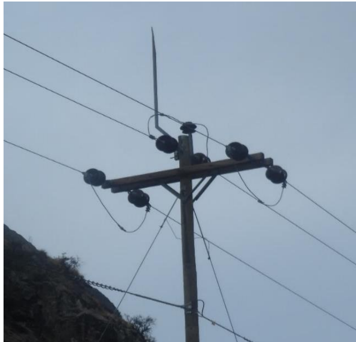
Figura N° 2.13: Pararrayo Tipo Franklin Elaboración propia.
