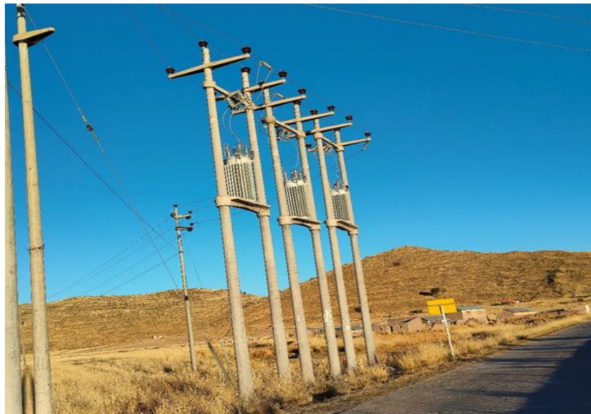
Figura N° 3.30: Regulador de Tension Lampa.
