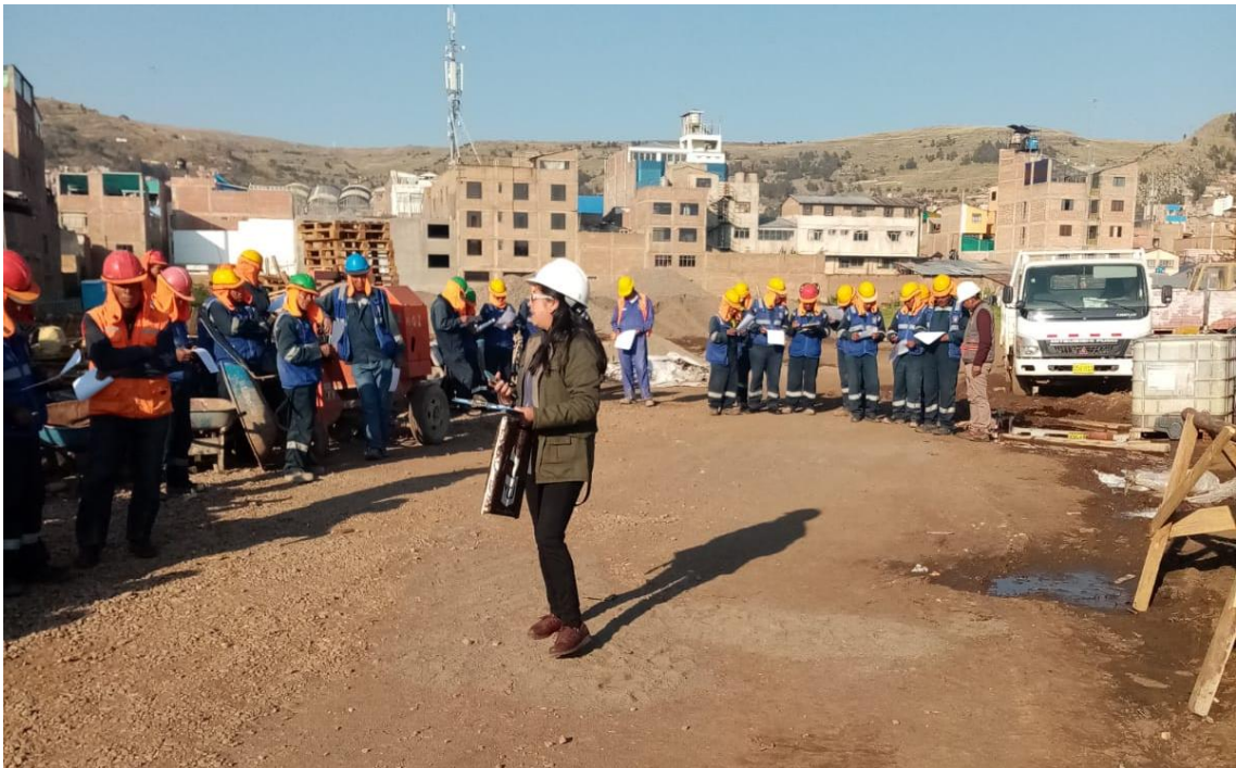
Figura 26. Indicaciones para el llenado del cuestionario de la investigación a los obreros
