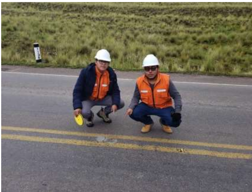
VISITA A CAMPO PARA VERIFICACION DE ESTADO DE LA VIA
