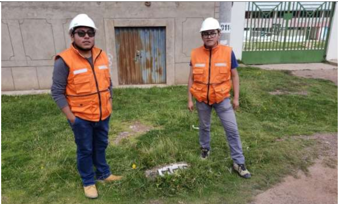
VISITA A CAMPO PARA VERIFICACION DE ESTADO DE LA VIA
