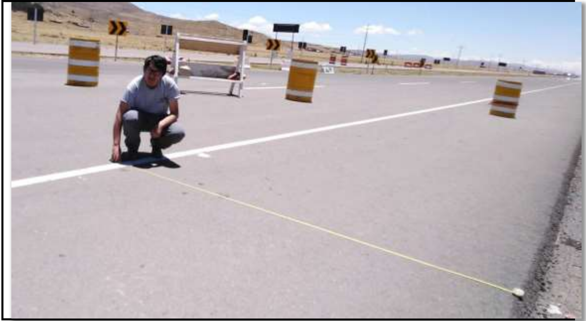
BERMA DEL NUEVO TRAMO DE CARRETERA PAUCARCOLLA – JULIACA
