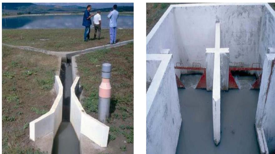
*Figura 61:* Repartidor de caudales
