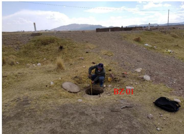
*Figura 46:* Buzón de llegada sistema de conducción de las aguas residuales
