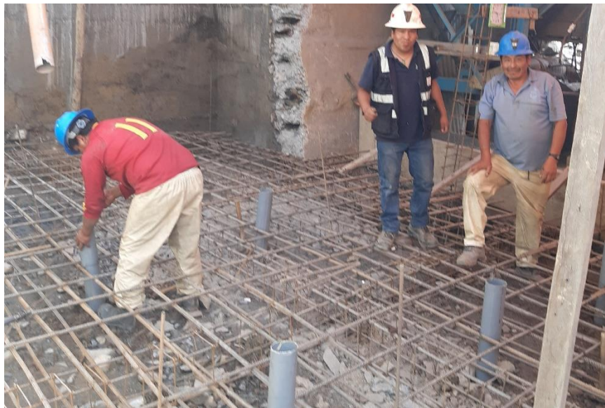
Anexo 9. Imagen de construcción de plataforma para instalar molinos en otra unidad
