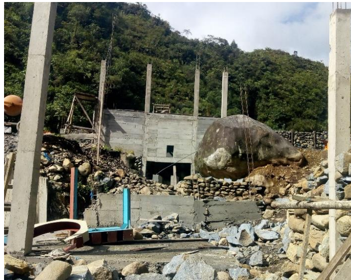
Figura 9. Construcción de la infraestructura
