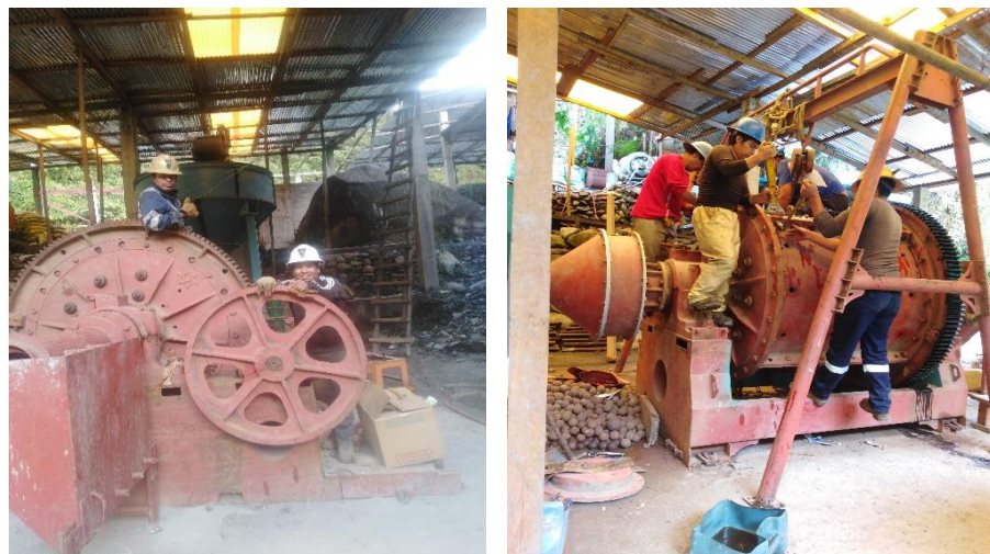
Figura 10. Montaje, instalación de los molinos
