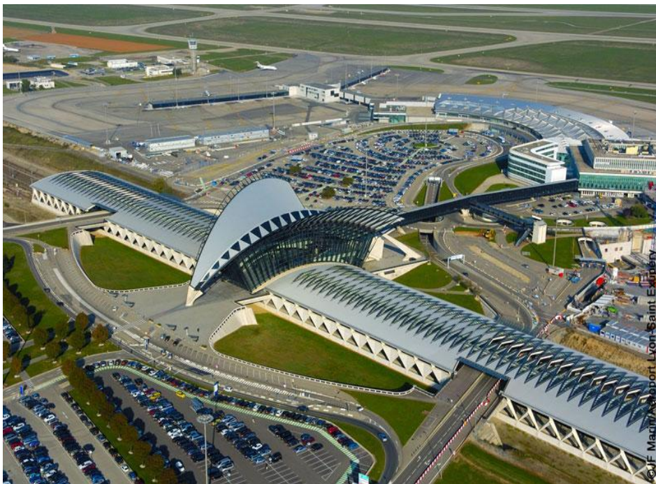
Figura 18: Estación de Lyon Saint - Satolas Exterior
