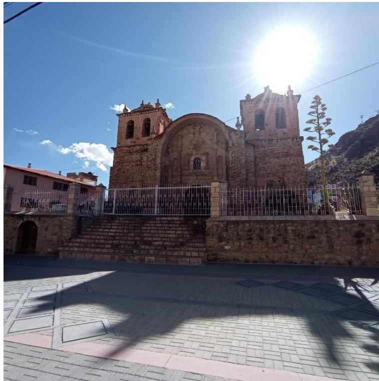
Figura 72: Fachada Principal del Templo de la Ciudad de Putina
