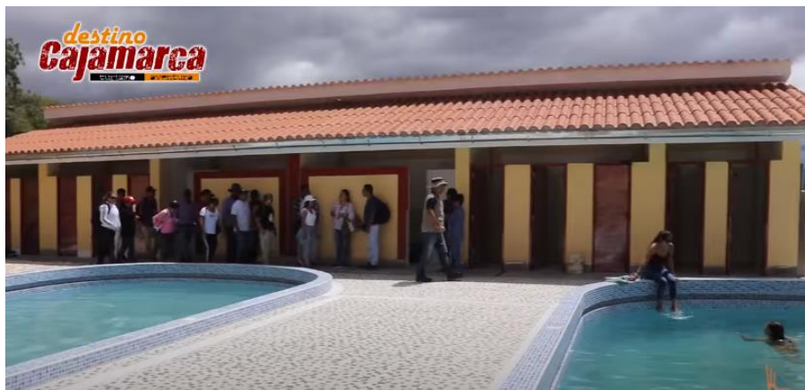
Figura 37: Zona de vestuarios del centro turístico termal chancay baños
