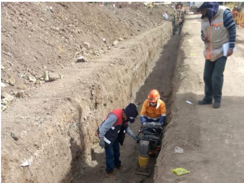
Fotografía 4. Compactación del terreno para ubicar las tuberías
