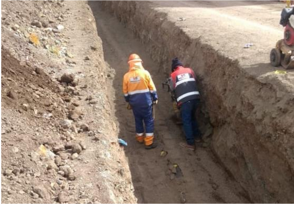
Fotografía 3. Excavación para colocar las tuberías
