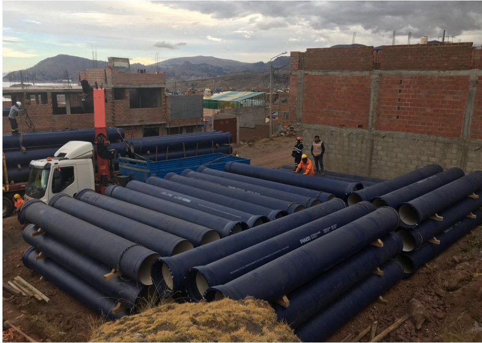
Fotografía 5. Tuberías para la instalación
