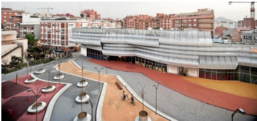
Figura 12: Vista del Mercado Municipal Rubí
