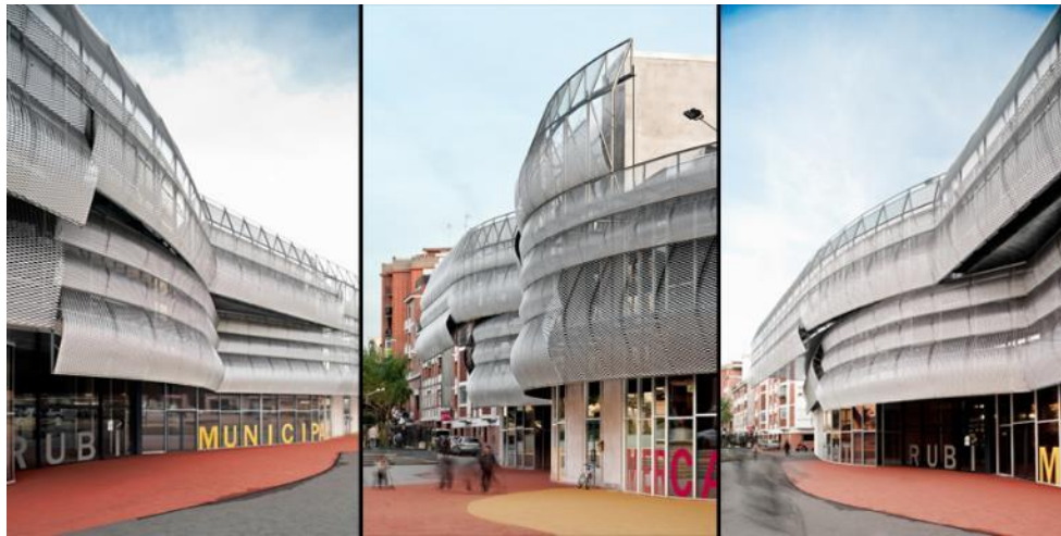
Figura 17: Vista de elementos estructurales
