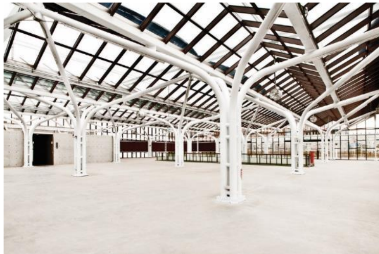
Figura 10: Estructura de pilares y cubierta sistema muro cortina
