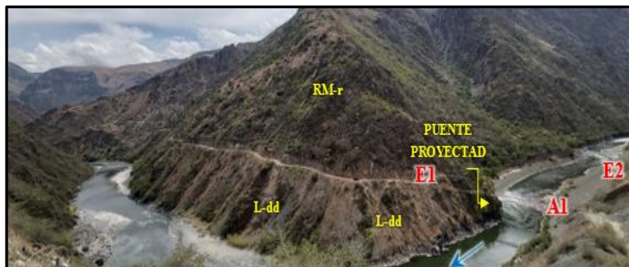
Figura 50. Vista de la Unidad Montaña en Roca Volcánica (RM-rv) Fuente: Elaboración propia.
