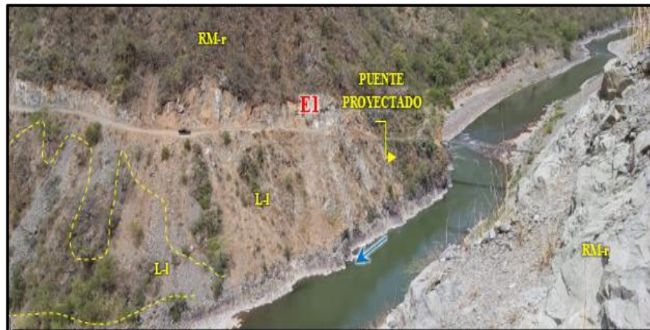
Figura 51. Vista de Laderas en la margen derecha (L-l).
