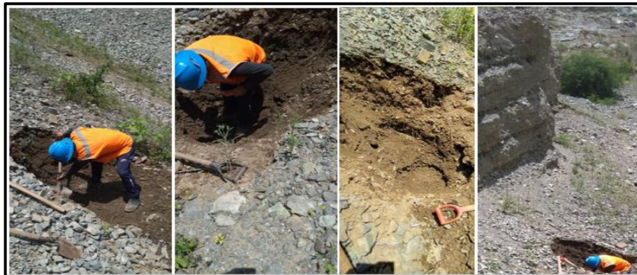
Figura 75. Excavación en la zona de emplazamiento del suelo reforzado tipo III. Fuente: Elaboración propia.
