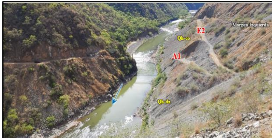
Figura 56. Vista de los Depósitos de Deslizamiento ( Qh-dz ). Fuente: Elaboración propia.
