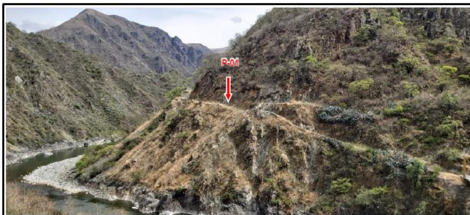
Figura 62. Vista del punto de Perforación P-01 - Margen Derecha.
