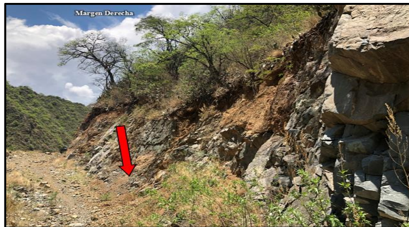
Figura 47. Vista del talud de la margen derecha donde se emplazará la estructura E1.
