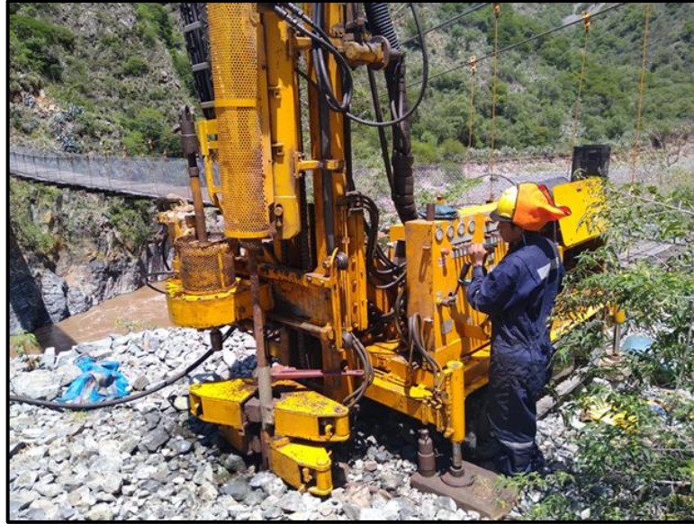
Figura 11. Equipo de perforación diamantina. Fuente: Elaboración propia.
