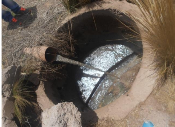
Ingreso de aguas residuales a la laguna facultativa del distrito de Pucara
