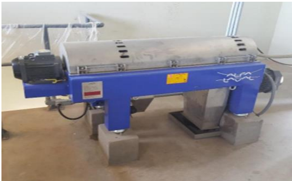
Figura 35. Centrífuga para lodos de la PTAR Yunguyo
