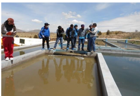
Sedimentador de la planta de tratamiento de José Domingo Choquehuanca
