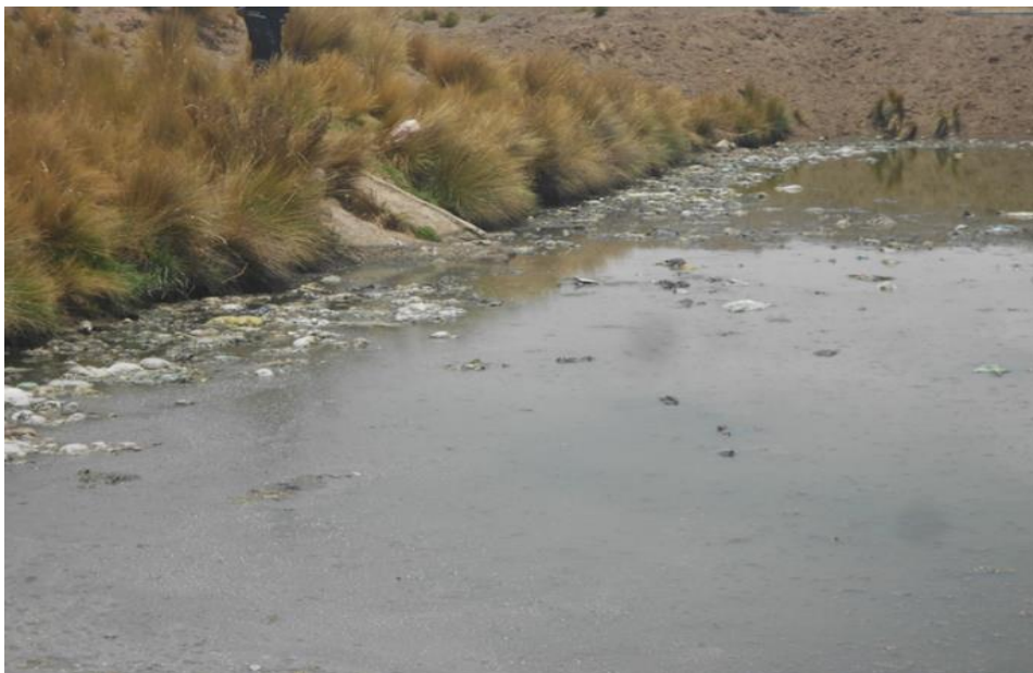
Figura 24. Vista de las lagunas facultativas de la planta de tratamiento de aguas residuales de Pucará
