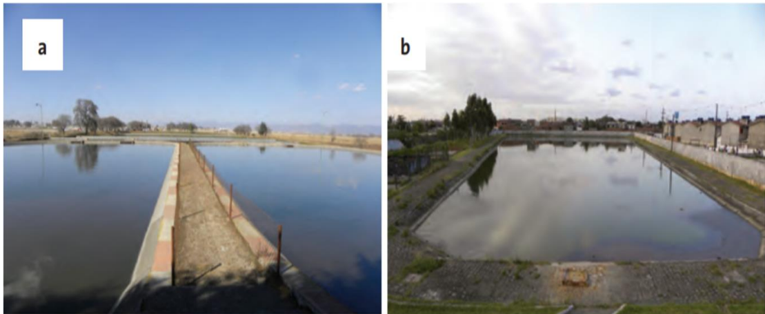
Figura 8. Lagunas de estabilización de las Planta de tratamiento de aguas residuales de México y Brasil
