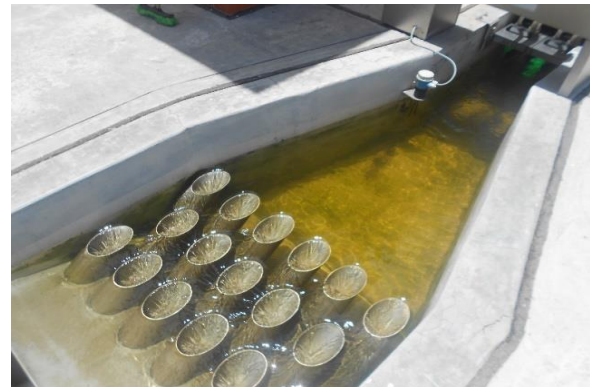
Aliviadero de efluente de la PTAR Yunguyo
