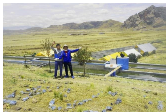
Filtro percoladores de José Domingo Choquehuanca
