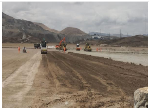
Foto 34. Compactación de material lastre en accesos.
