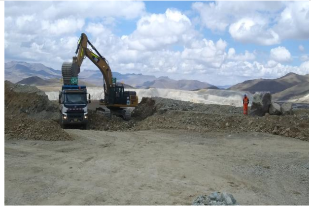
Foto 182. Corte y carguío de material de préstamo.
