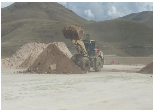
Foto 109. Mezcla de material orgánico con cargador frontal.
