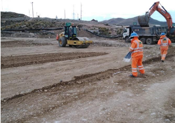
Foto 167. Compactación de arcilla en canal.
