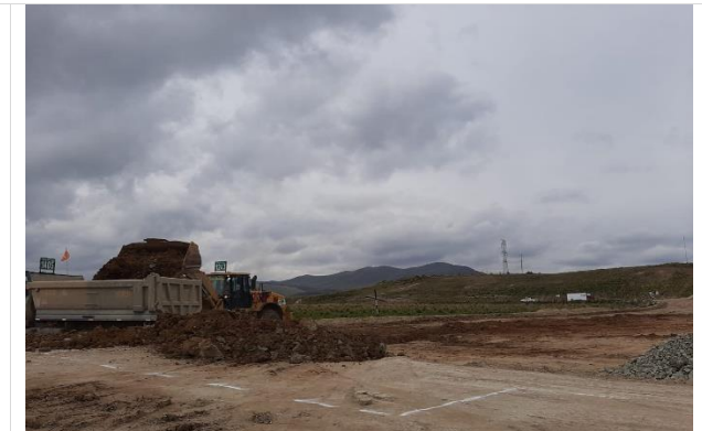
Foto 170. Carguío y transporte de material excavado.
