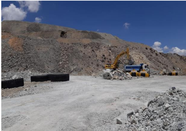
Foto 61. Carguío de material de préstamo..
