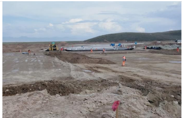
Foto 158. Colocación de arcilla.
