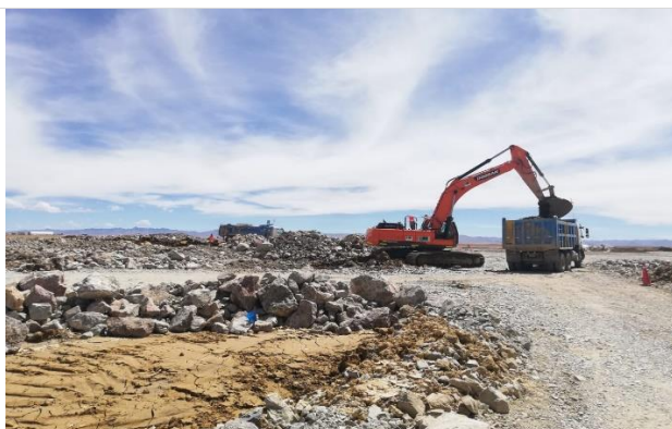
Foto 49. Corte y carguío de material suelto.
