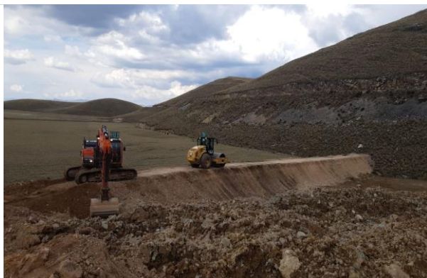
Foto 126. Compactación de dique.
