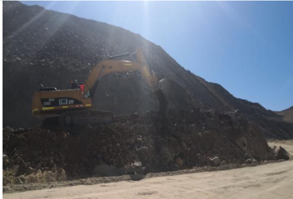
Foto 55. Desbroce de cantera de préstamo.
