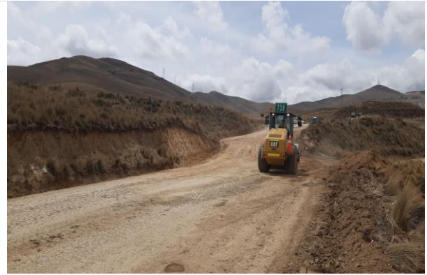
Foto 38. Mantenimiento de vías.
