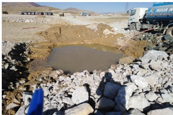
Foto 197. Bombeo de agua con cisterna.
