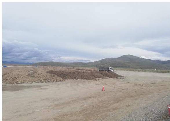
Foto 110. Acopio de material para mezcla.
