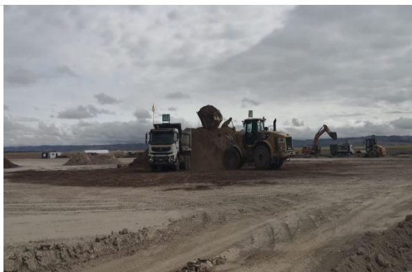
Foto 107. Mezcla de material orgánico y G.M.
