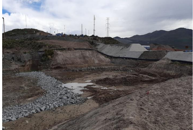
Foto 172. Perfilado de talud.
