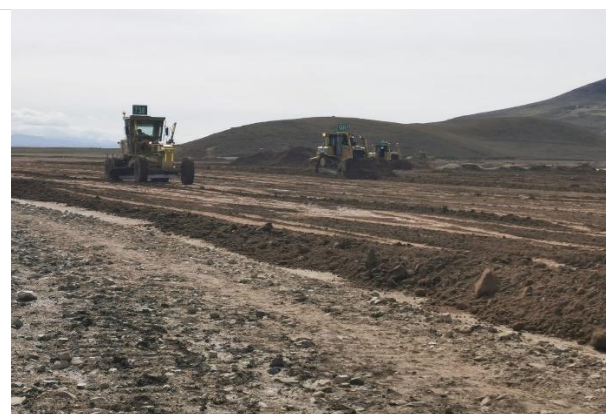
Foto 115. Esparcido de material orgánico en plataforma..
