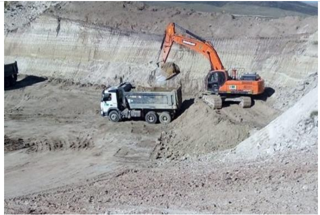
Foto 154. Corte y carguío de arcilla.
