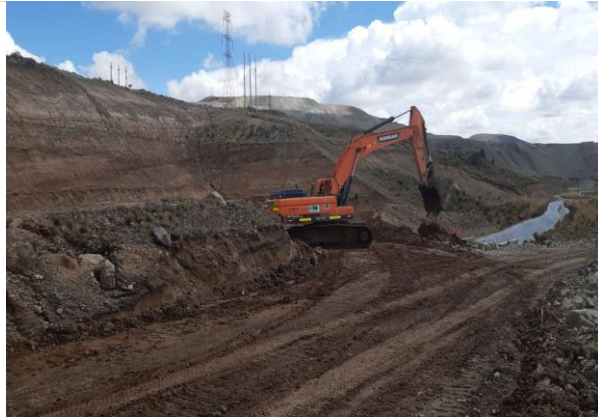
Foto 130. Conformación de bermas.
