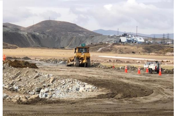
Foto 32. Conformación de material lastre.
