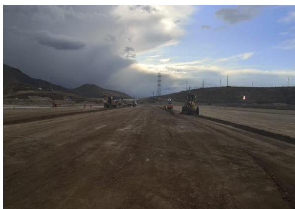
Foto 142. Compactación de sección de canal
