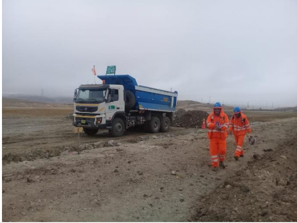
Foto 27. Descarga de material lastre.
