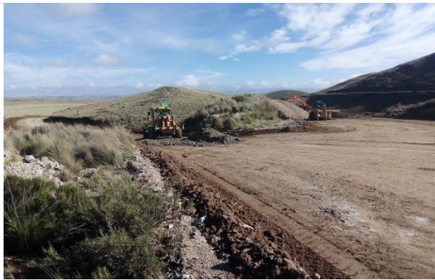
Foto 185. Relleno en acceso..
