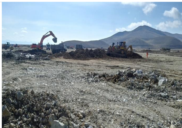
Foto 123. Excavación para canal.
