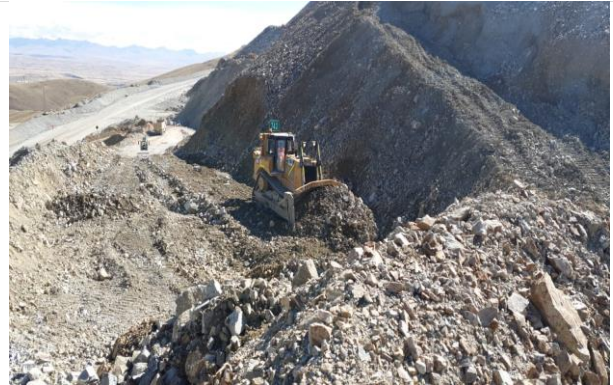
Foto 56. Desbroce de material grueso en cantera.
