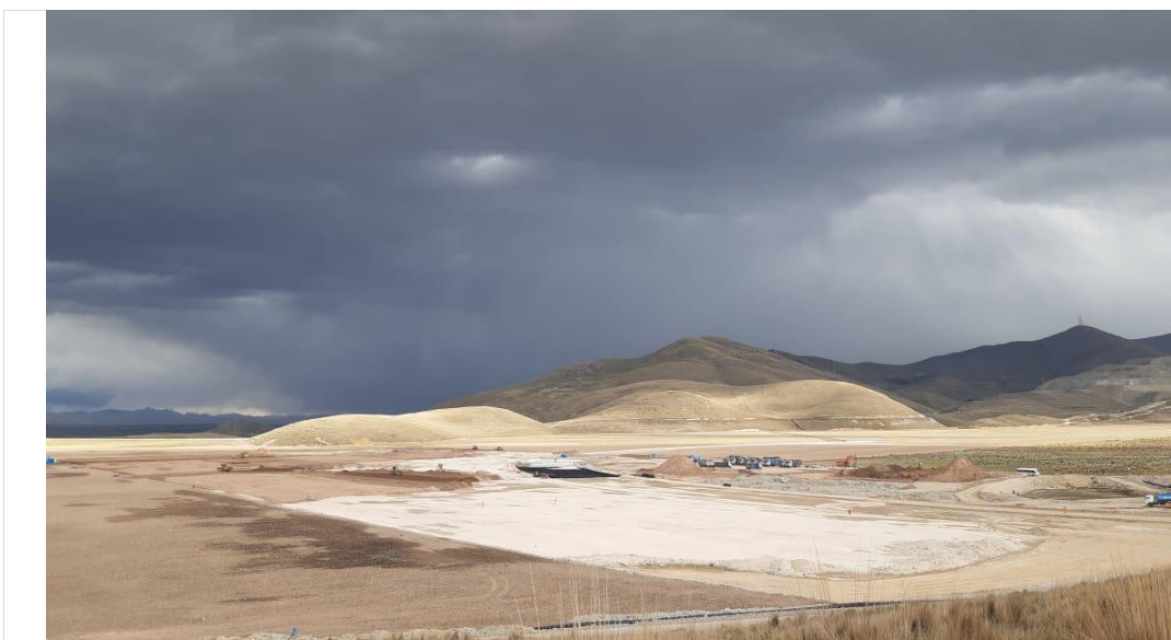
Foto 229. Trabajos de conformación y compactación de arcilla en plataforma y colocación de material orgánico en plataforma - Febrero.2021
