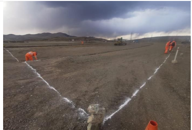
Foto 04. Replanteo topográfico.
