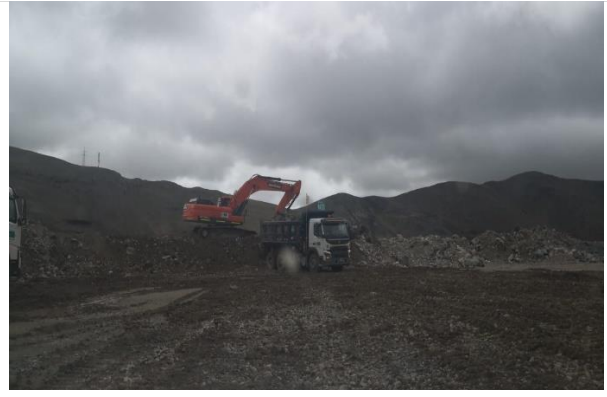
Foto 180. Carguío de material de préstamo.
