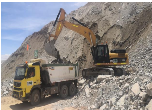
Foto 25. Carguío de material lastre.
