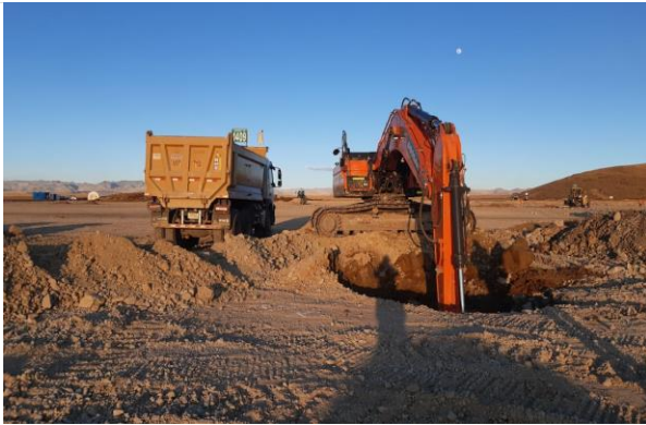
Foto 191. Excavación de pozo.
