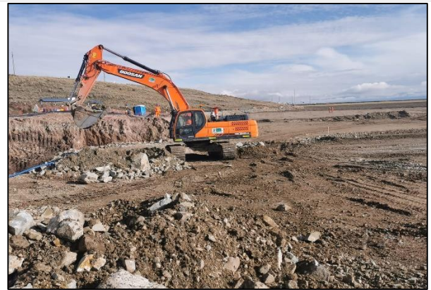
Foto 148. Corte y carguío de material en canal.
