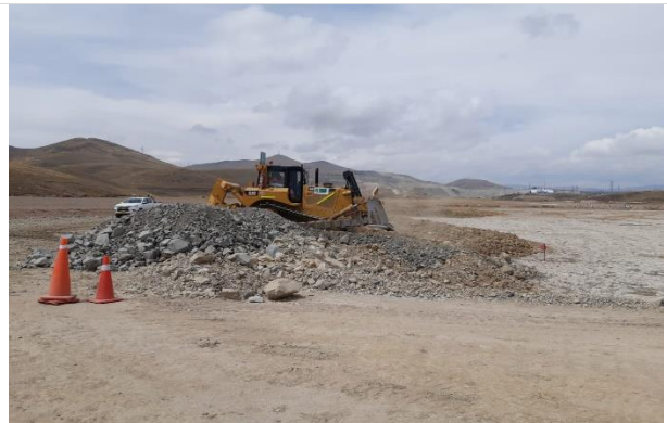
Foto 66. Conformación de material de préstamo en plataforma.
