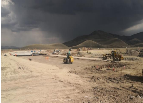
Foto 165. Compactación de arcilla en canal.
