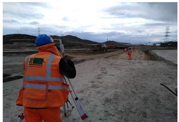
Foto 134. Corte de canal según sección.
