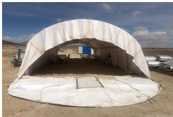
Foto 14. Armado de comedor en obra.
