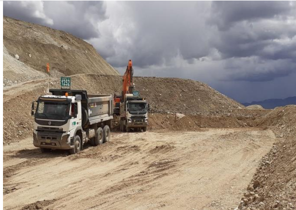
Foto 181. Carguío de material de préstamo en cantera.
