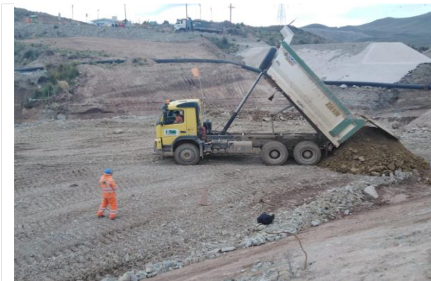
Foto 230. Control de ciclo de transporte, tiempos de descarga en plataforma.
