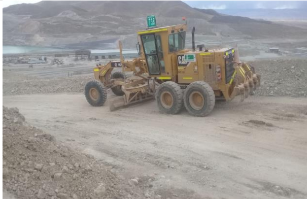
Foto 37. Mantenimiento de vías.
