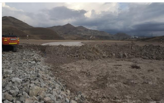
Foto 119. Excavación para canal.
