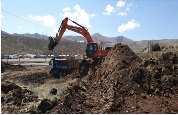
Foto 95. Carguío de material TopSoil.
