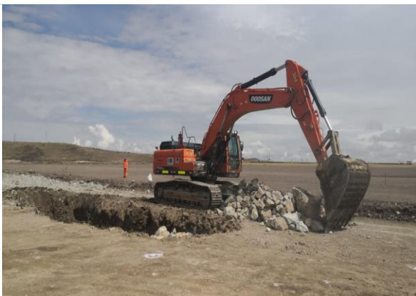
Foto 193. Excavación de pozo.
