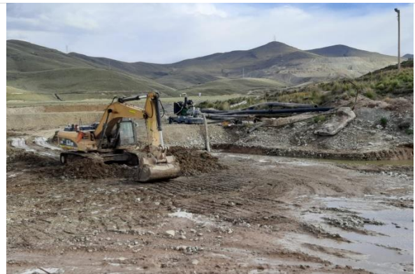
Foto 178. Relleno de paso para tuberías.
