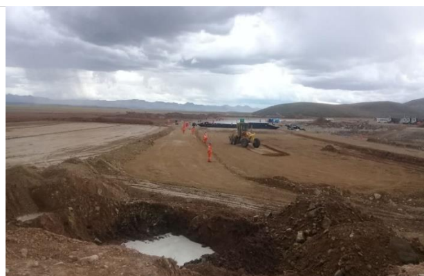
Foto 140. Verificación topográfica de niveles en canal.
