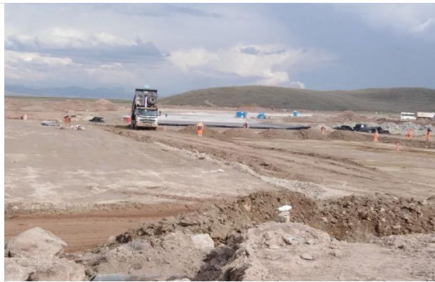
Foto 157. Colocación de arcilla.
