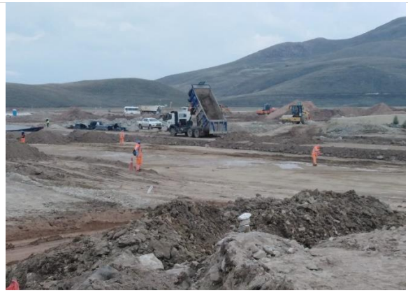
Foto 160. Colocación de arcilla en canal.
