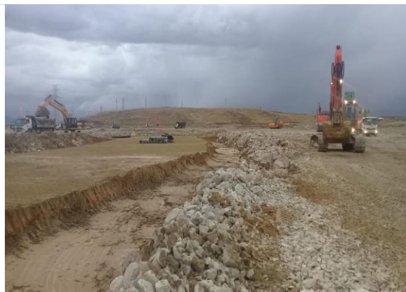
Foto 124. Excavación para canal.
