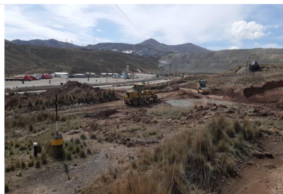
Foto 92. Desbroce de cantera Topsoil.
