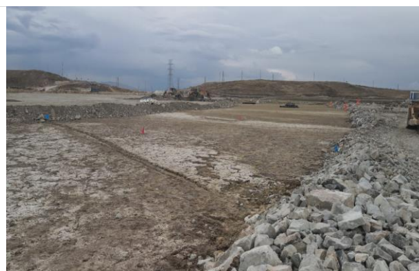
Foto 120. Excavación para canal.
