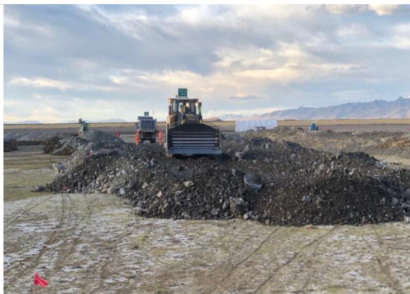
Foto 33. Conformación de material lastre.
