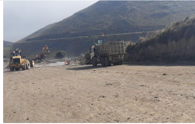
Foto 179. Transporte de material de préstamo.
