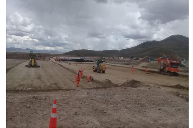
Foto 168. Compactación de arcilla en canal.
