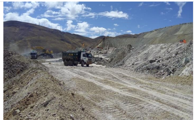
Foto 60. Carguío de material de préstamo.
