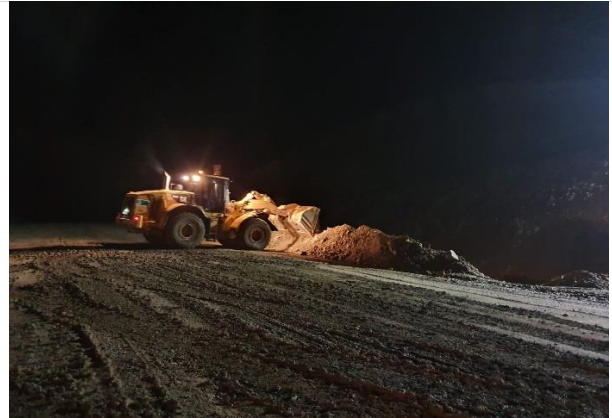
Foto 131. Conformación de bermas de seguridad.
