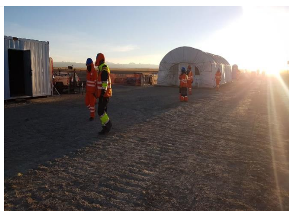
Foto 16. Campamento en obra.
