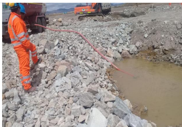
Foto 199. Bombeo de agua de poza.
