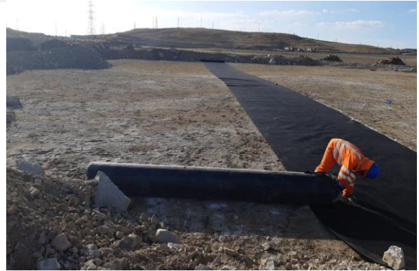
Foto 72. Colocación de geotextil.
