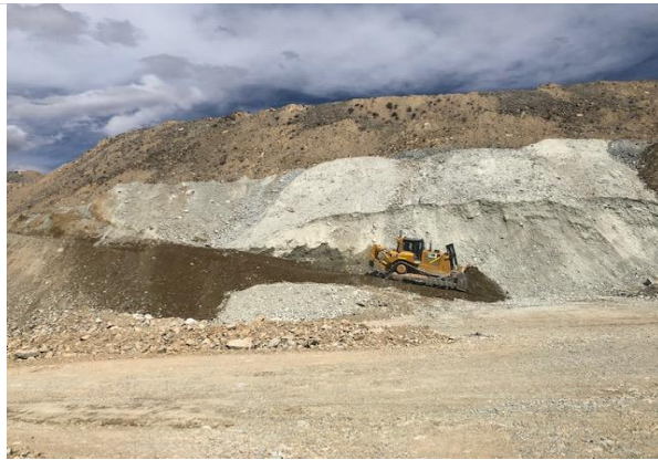
Foto 57. Desbroce de cantera de préstamo.
