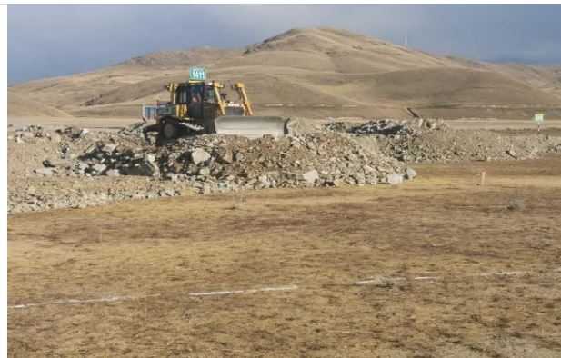
Foto 44. Corte y relleno con tractor D6.
