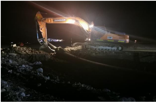
Foto 175. Colocación de tubería.
