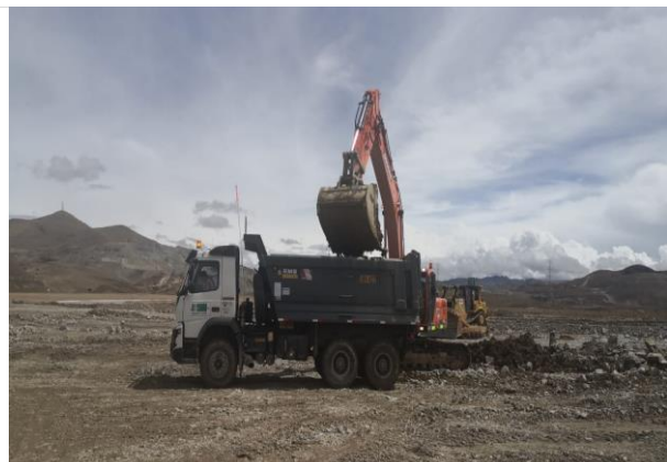
Foto 194. Excavación de pozo.
