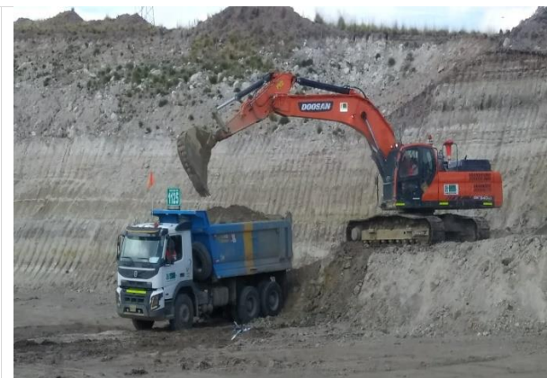
Foto 76. Carguío y transporte de arcilla.
