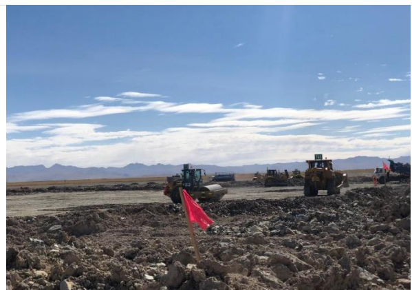
Foto 68. Compactación de material lastre.
