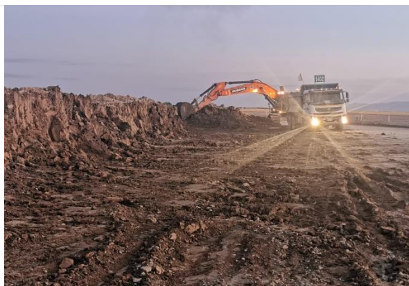
Foto 204. Carguío de relave acopiado en plataforma.
