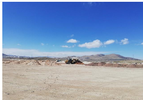
Foto 108. Acopio de material orgánico en plataforma.
