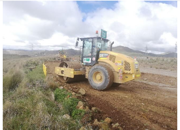
Foto 188. Compactación de acceso.
