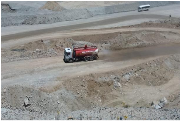
Foto 19. Regado de vías y accesos.
