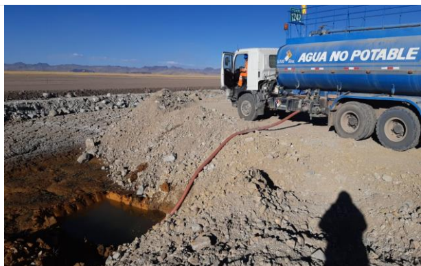
Foto 196. Bombeo de agua de poza.
