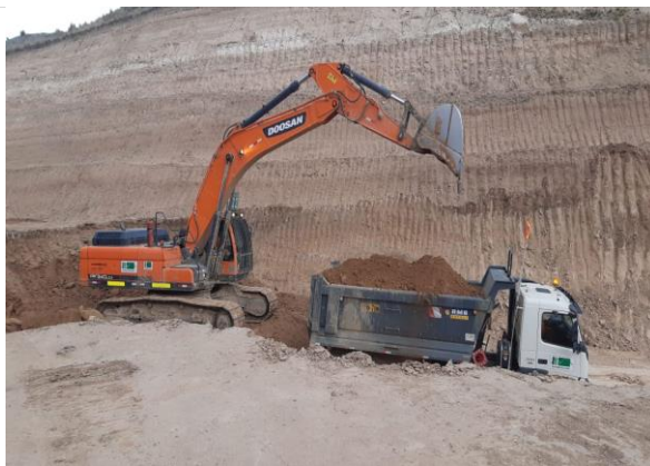
Foto 104. Carguío y transporte de material G.M.
