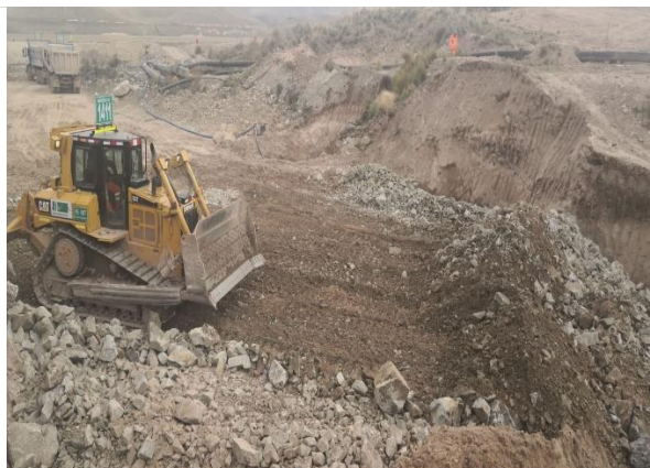
Foto 136. Corte de canal según sección
