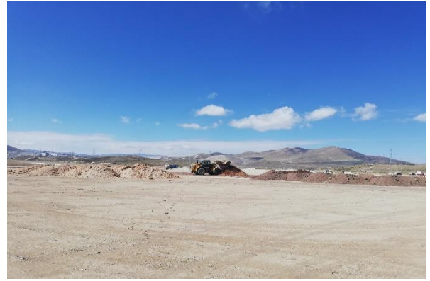
Foto 96. Acopio de material Topsoil en plataforma.
