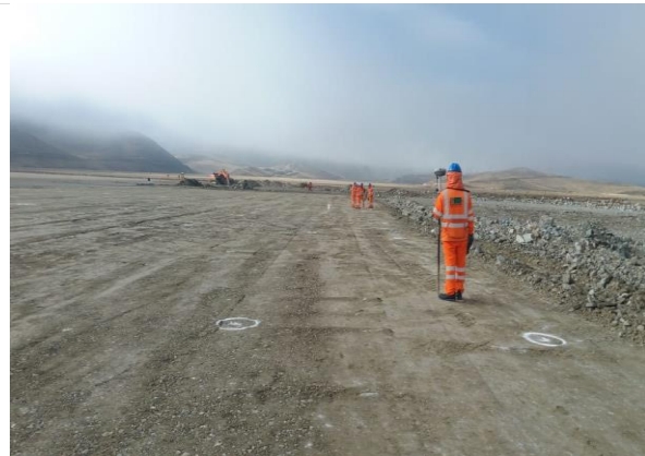
Foto 03. Control topográfico en plataforma.
