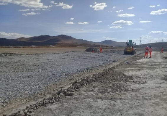
Foto 31. Compactado de material lastre en accesos.
