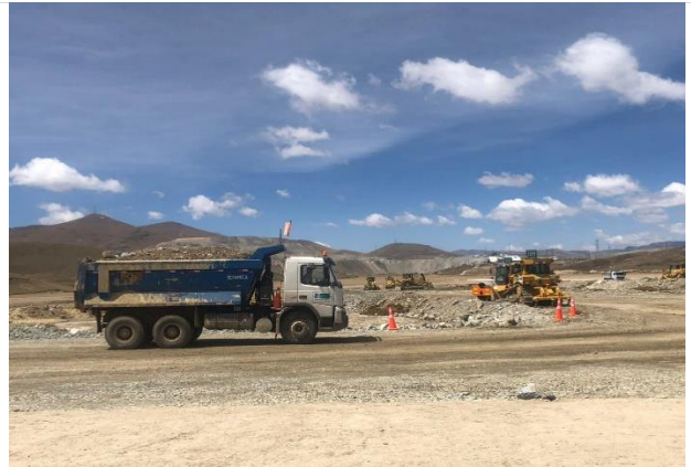
Foto 62. Transporte de material de préstamo.
