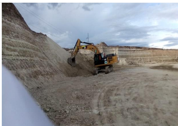
Foto 87. Reconfiguración de taludes.
