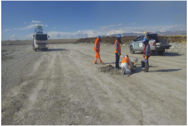
Foto 223. Ensayo cono de arena en plataforma a nivel de capa sub-rasante.
