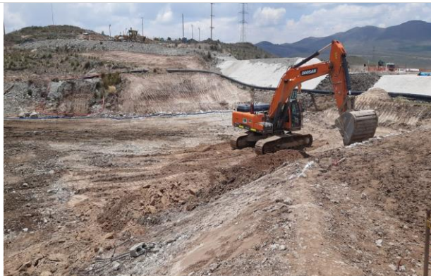
Foto 169. Perfilado de talud para tuberías.
