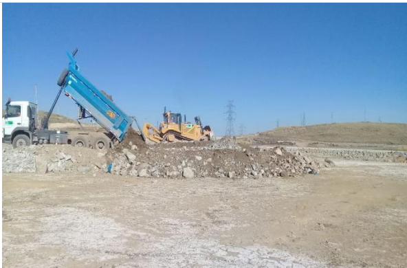
Foto 65. Esparcido de material de préstamo en plataforma.
