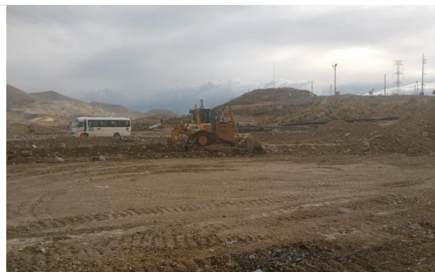
Foto 113. Esparcido de material Topsoil.
