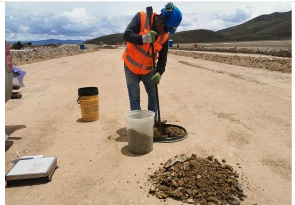
Foto 225. Ensayo de reemplazo de agua en sección canal central a nivel sub-rasante.
