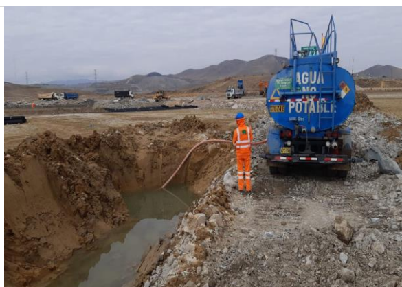
Foto 198. Bombeo de agua.
