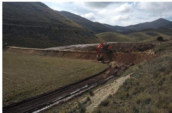
Foto 127. Conformación de dique.
