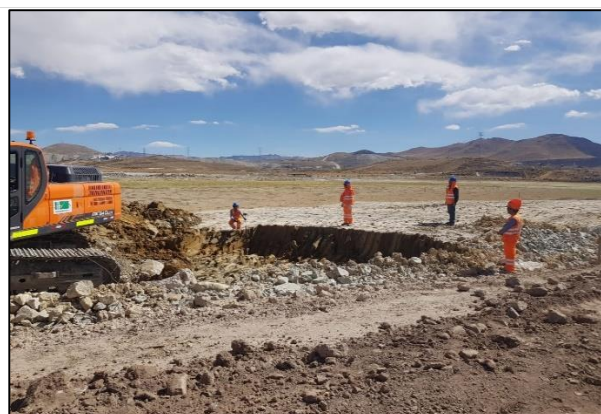
Foto 51. Corte de material suelto.
