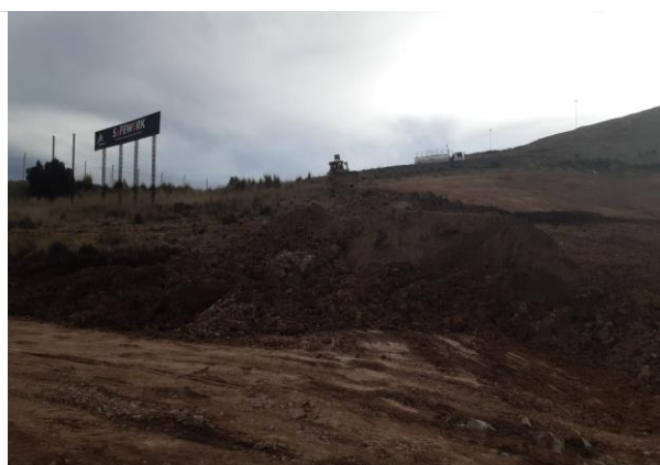
Foto 94. Desbroce de cantera de Topsoil.
