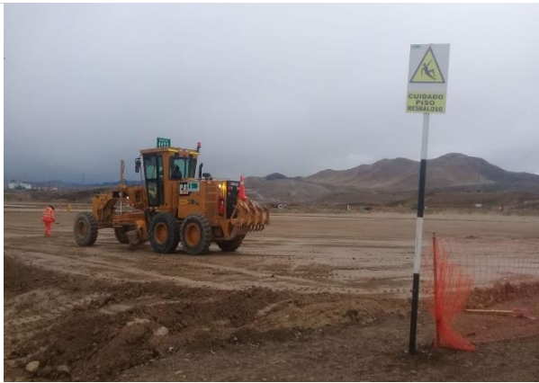
Foto 81. Nivelación de capa de arcilla.
