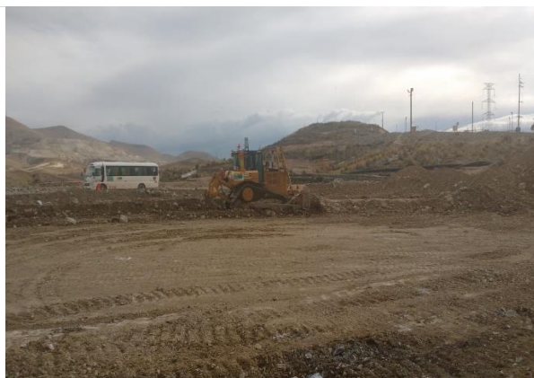
Foto 45. Corte y relleno compensado de material..
