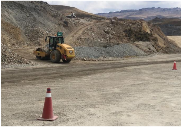
Foto 187. Compactación de acceso.
