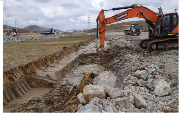
Foto 146. Excavación de material en canal.
