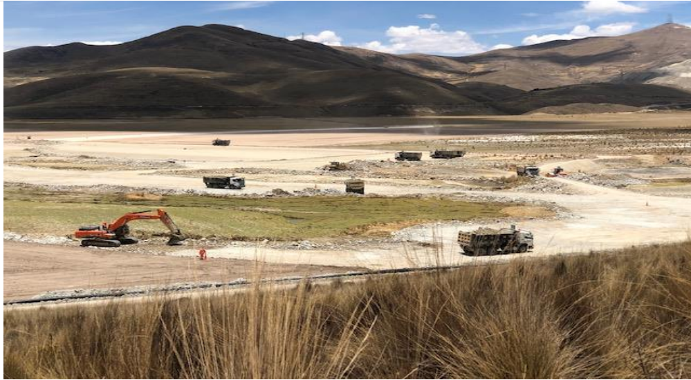
Foto 226. Trabajos de reemplazo y eliminación de material saturado en plataforma. – Noviembre 2020
