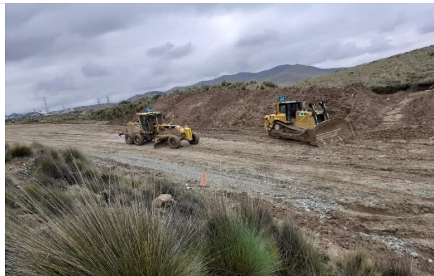
Foto 186. Relleno y conformación en acceso.
