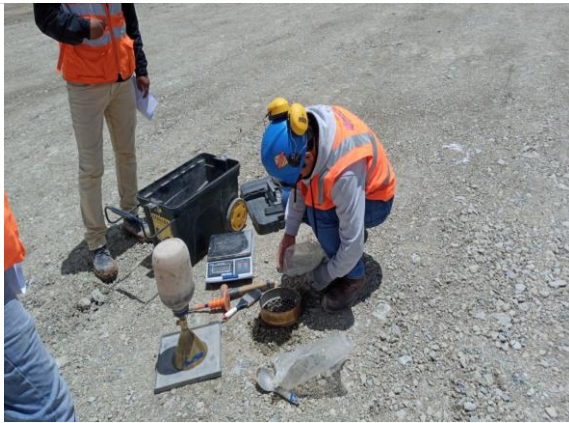
Foto 224. Ensayo de reemplazo de agua en canal central a nivel sub-rasante.
