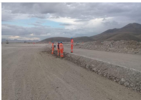
Foto 141. Perfilado de sección de canal.
