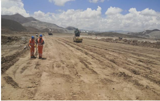
Foto 79. Compactación de capa de arcilla en plataforma.
