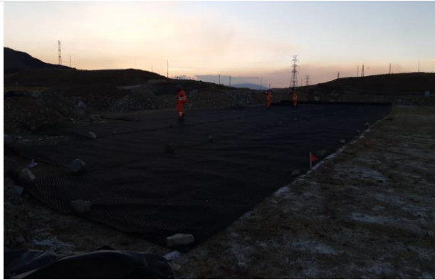
Foto 71. Colocación de geotextil.
