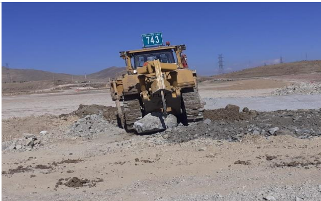
Foto 43. Corte y relleno con tractor D6.
