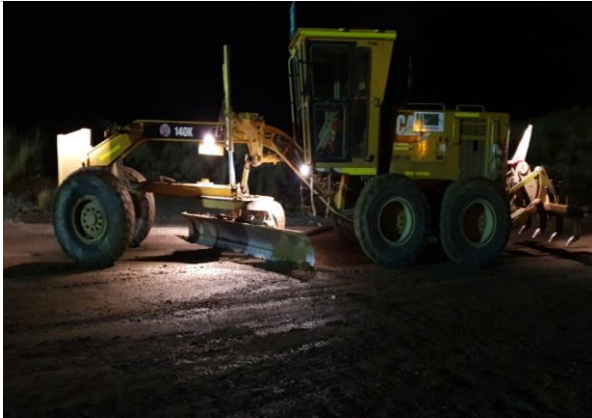
Foto 39. Mantenimiento de vías.
