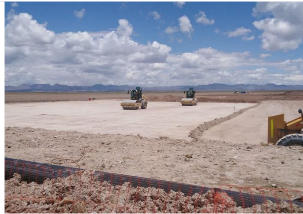
Foto 82. Compactación de arcilla en plataforma.
