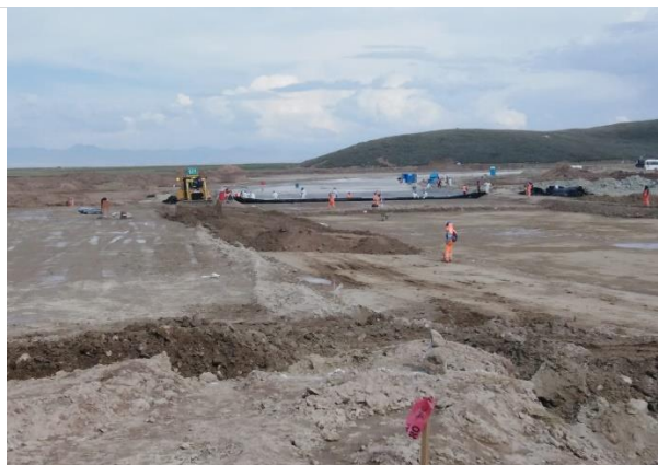
Foto 135. Corte de canal según sección.
