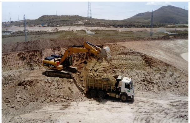
Foto 74. Carguío y transporte de arcilla.
