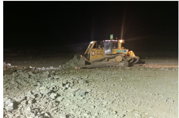
Foto 58. Desbroce de material de cantera
