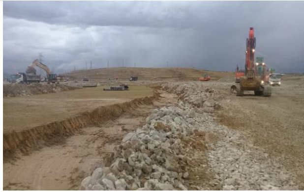
Foto 145. Excavación de material en canal.
