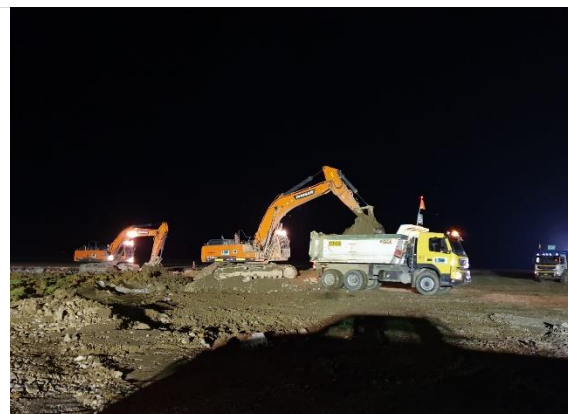
Foto 52. Carguío de material inadecuado de plataforma.
