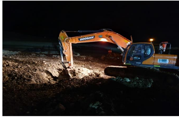
Foto 192. Excavación de pozo.
