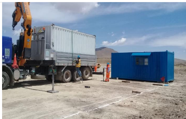
Foto 13. Descarga de oficinas en obra
