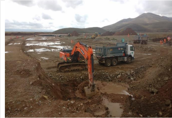
Foto 147. Excavación de material en canal.
