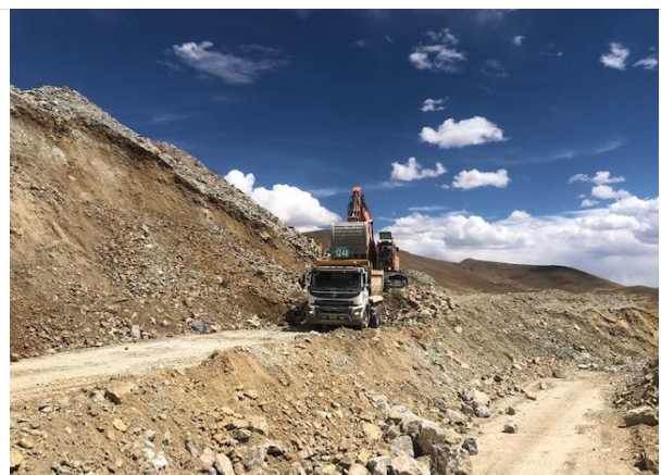
Foto 26. Carguío de material lastre en cantera
