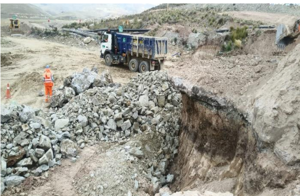
Foto 125. Demolición de material existente.
