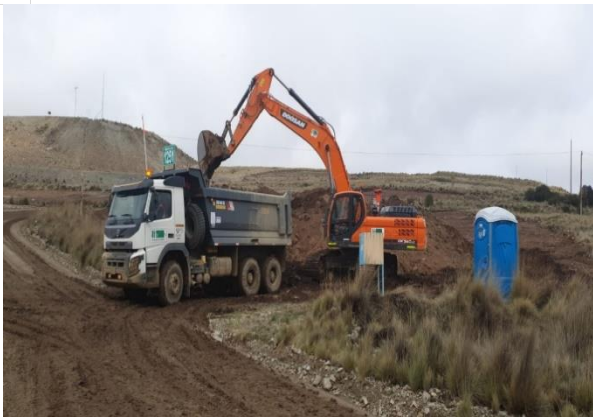
Foto 97. Carguío de material Topsoil.
