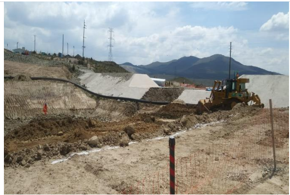
Foto 176. Colocación de tuberías.
