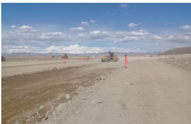
Foto 139. Nivelación de canal.
