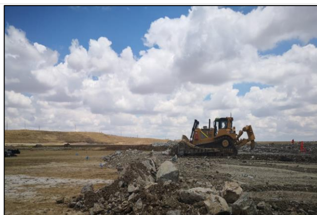
Foto 46. Corte y relleno compensado.
