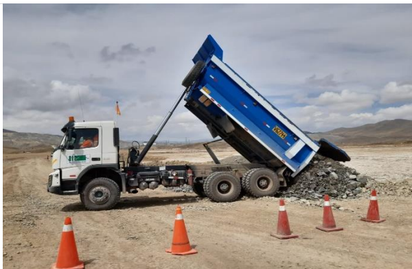
Foto 59. Descarga de material de préstamo.
