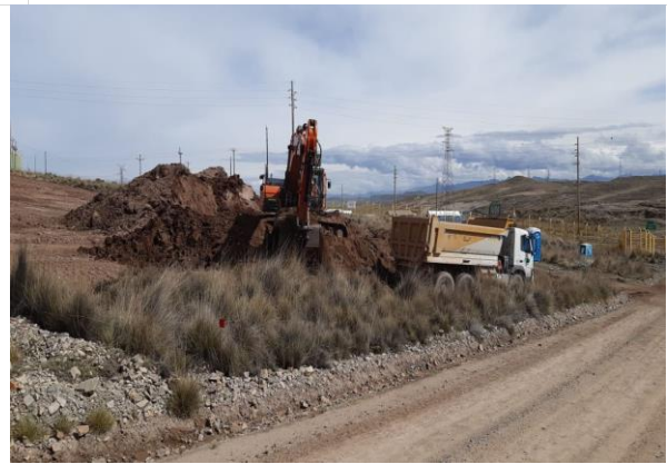
Foto 98. Carguío y transporte de material Topsoil.
