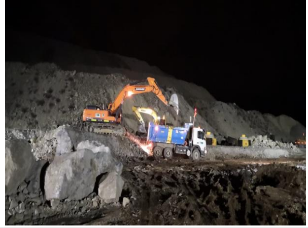
Foto 28. Carguío de material lastre
