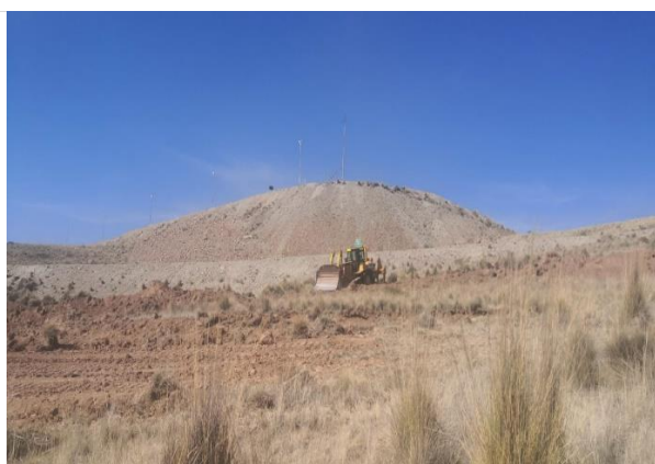
Foto 93. Desbroce de cantera de Topsoil.
