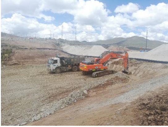
Foto 171. Replanteo topográfico en plataforma.
