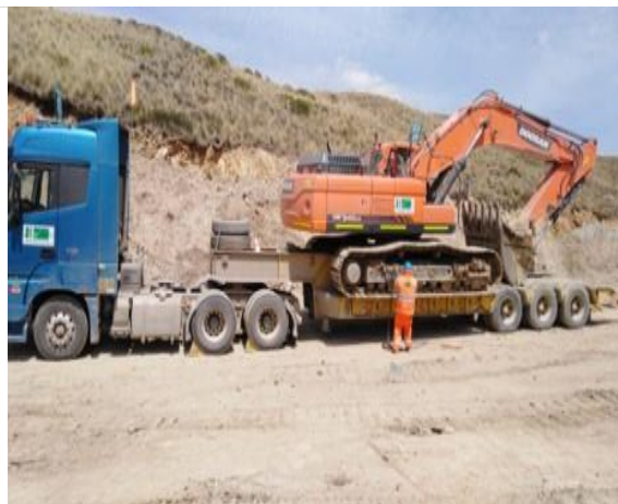
Foto 09. Movilización de excavadora.
