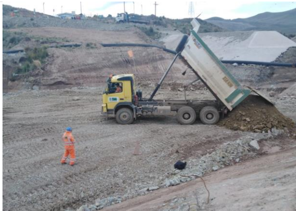
Foto 159. Colocación de arcilla en canal.
