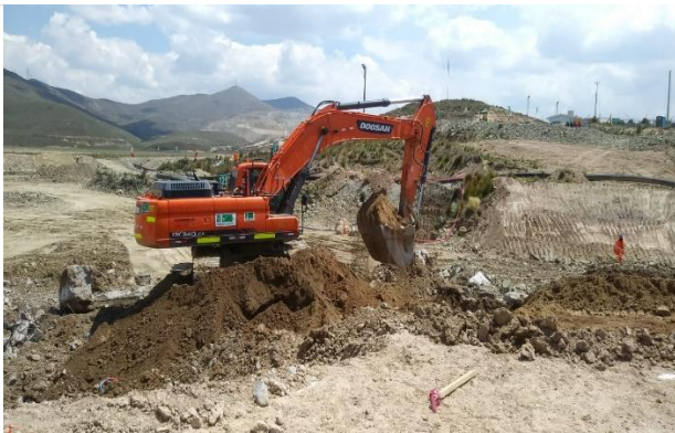
Foto 177. Relleno de zanja para tuberías.
