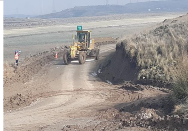
Foto 40. Mantenimiento de accesos en cantera.
