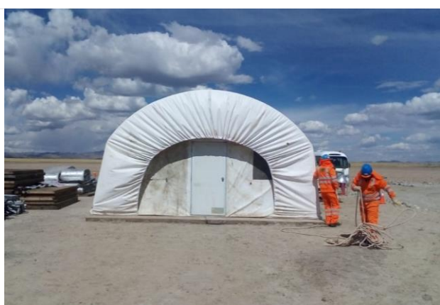
Foto 15. Comedor de obra armado.
