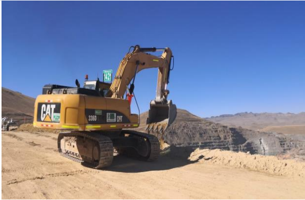
Foto 128. Conformación de bermas.
