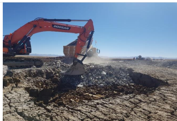
Foto 50. Corte de material suelto
