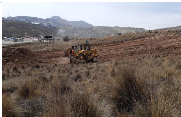
Foto 91. Desbroce de cantera de Topsoil..
