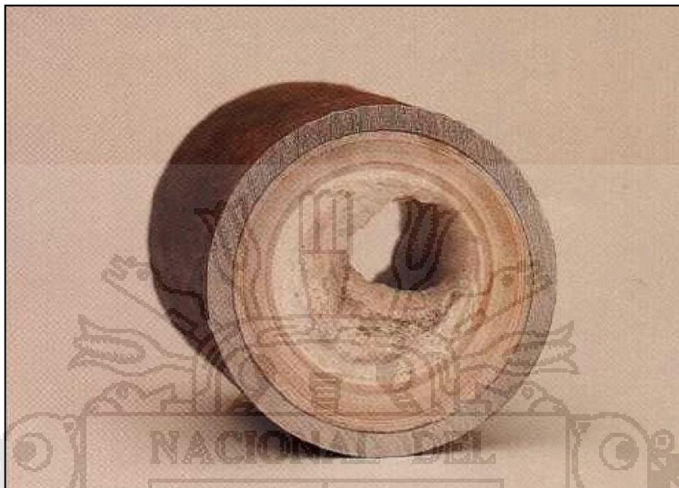
Fig. III – 04. Incrustaciones excesivas de fosfatos.
