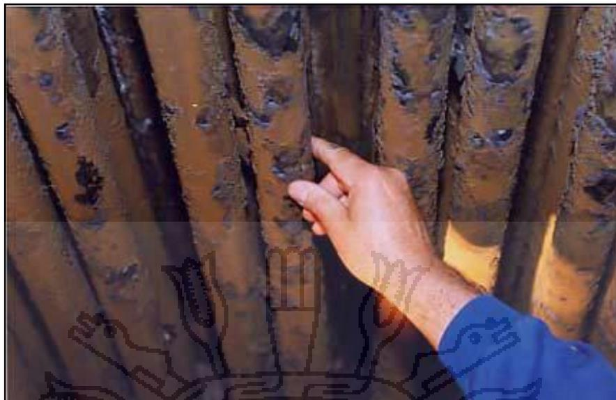
Fig. III – 07. Corrosión e incrustación.
