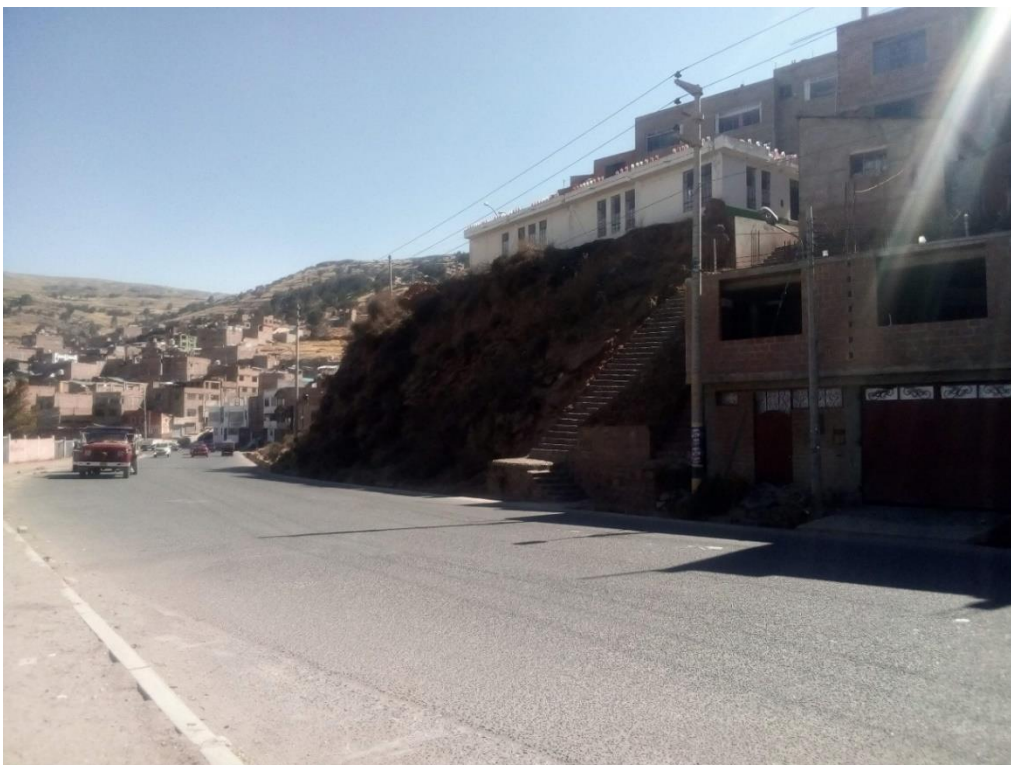
Figura 98. Vista de viviendas en crestas de talud en coordenadas 389180.66 m E, 8248694.42 m S
