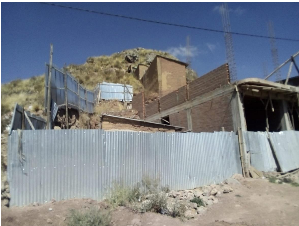
Figura 74. Vista de vivienda en construcción en ladera dependiente media en coordenadas 390099.86 m E, 8250223.59 m S
