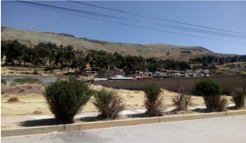
Figura 44. Vista de área urbana ubicada en ladera de pendiente baja y media en coordenadas 393781.33 m E, 8250938.13 m S
