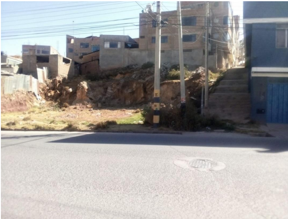
Figura 99. Corte de talud para construcción de vivienda en coordenadas 389132.25 m E, 8248661.52 m S
