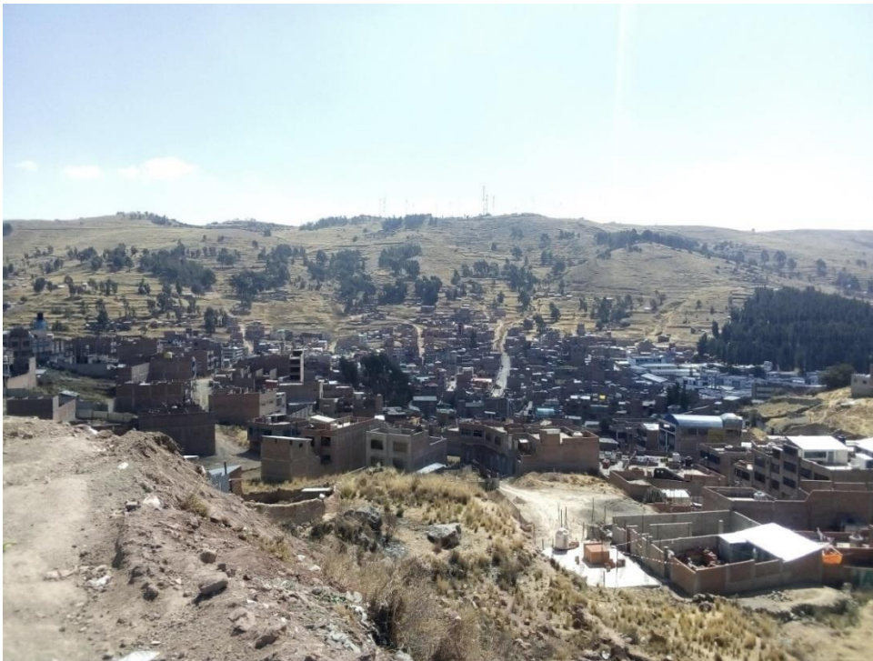
Figura 73. Vista de viviendas susceptibles a deslizamientos de detritos y flujos en coordenadas 390158.45 m E, 8250378.17 m S
