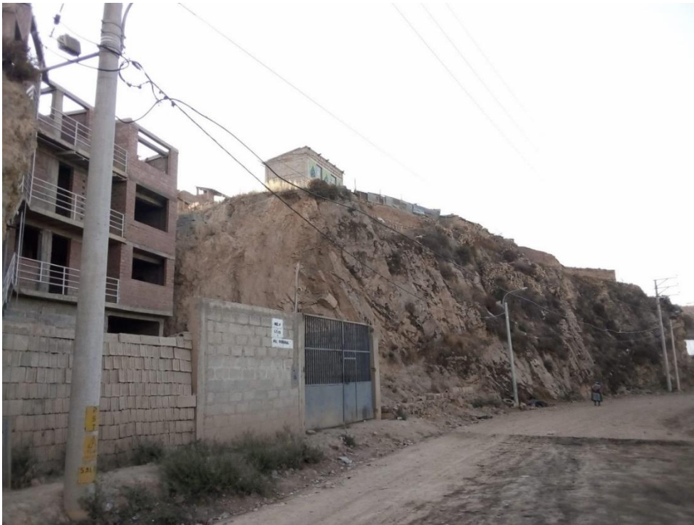
Figura 113. Vista de vivienda colindante a talud de corte para vía en coordenadas 392693.16 m E, 8245768.77 m S
