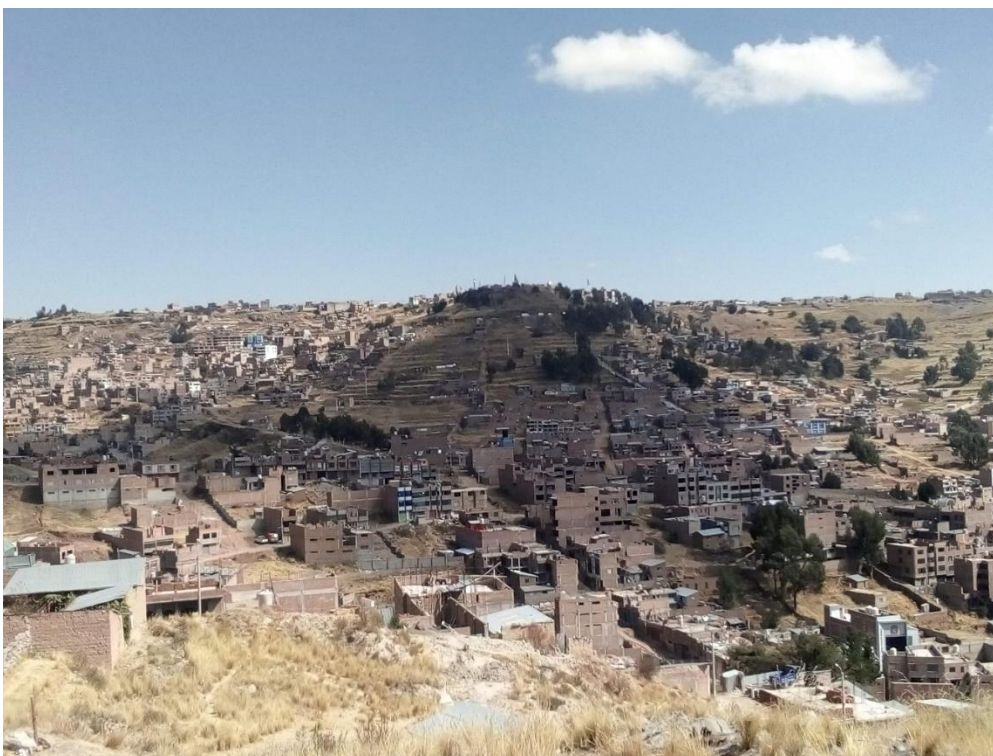
Figura 68. Vista de ladera de pendiente alta y media con presencia de zona urbana en coordenadas 389918.84 m E, 8250619.61 m S
