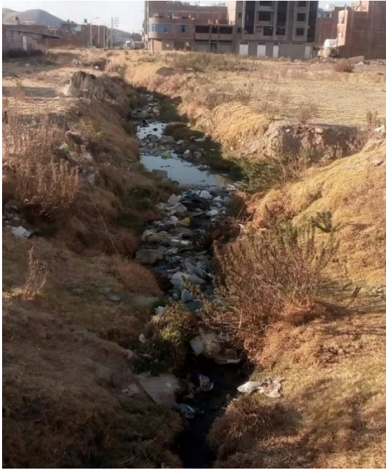
Figura 105. Vista de drenaje pluvial y aguas servidas en el centro poblado de salcedo en coordenadas 393020.96 m E, 8245290.22 m S
