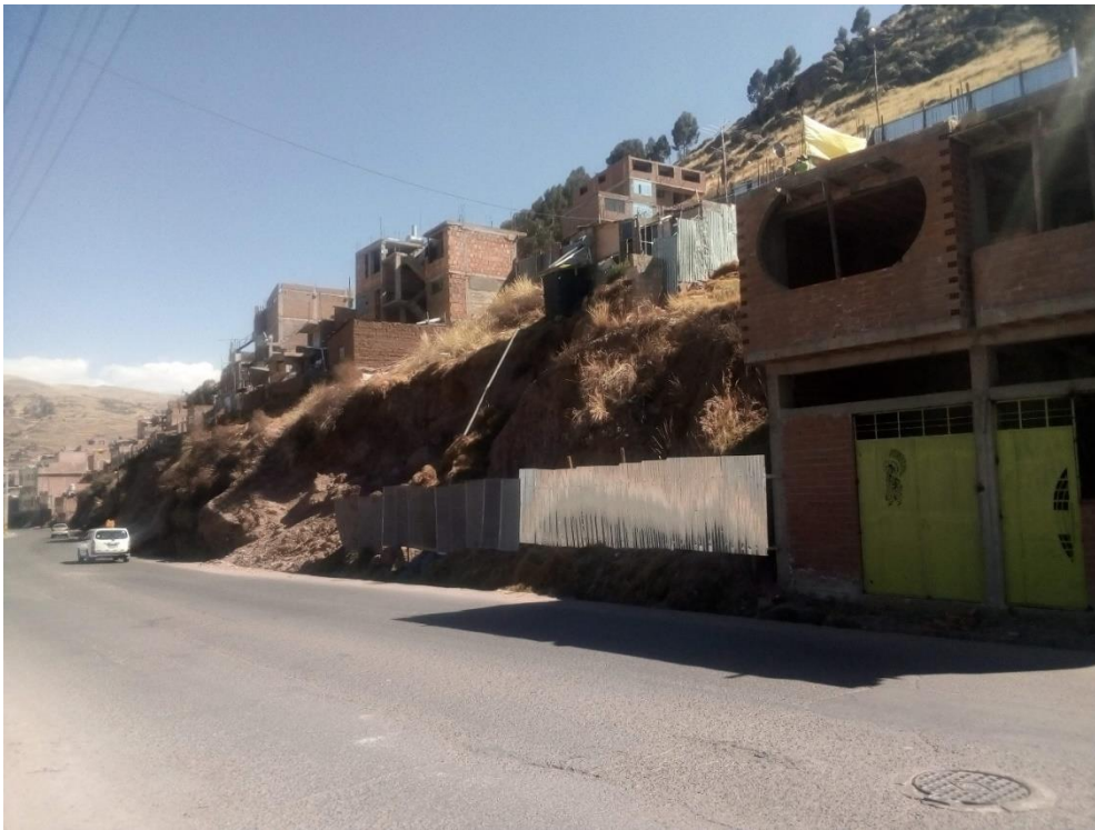
Figura 95. Vista de viviendas en ladera de pendiente alta en cresta de talud de corte colindante a vía de acceso al área urbana de la ciudad de Puno en coordenadas 389602.63 m E, 8249333.36 m S
