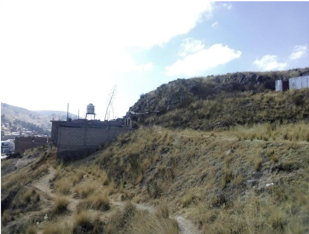
Figura 67. Vista lateral de ladera con presencia de viviendas colindantes susceptibles a flujos y desprendimientos de rocas en coordenadas 390350.29 m E, 8250071.36 m S
