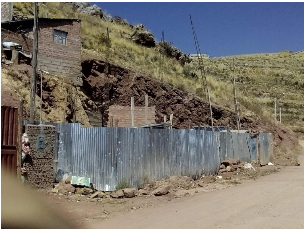
Figura 76. Vivienda en construcción en ladera de pendiente alta y presencia de vivienda aledaña a desnivel en coordenadas 390155.10 m E, 8250017.33 m S
