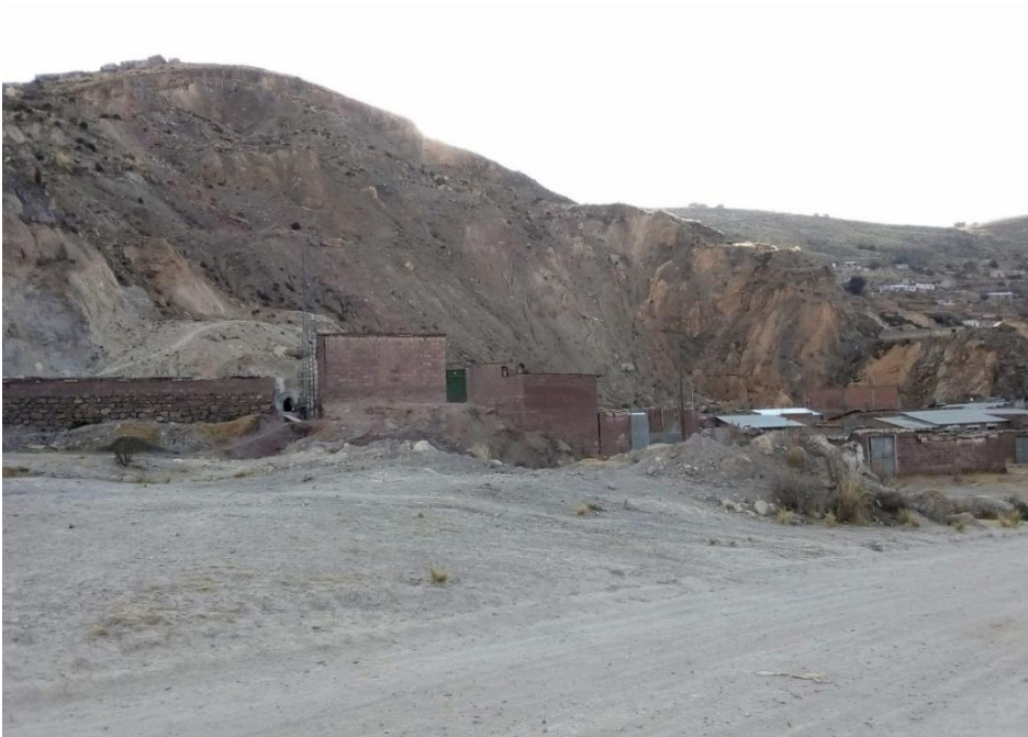
Figura 110. Vista de talud de corte con pendiente alta y asentamiento urbano de la ciudad de Puno en coordenadas 392620.72 m E, 8245422.66 m S
