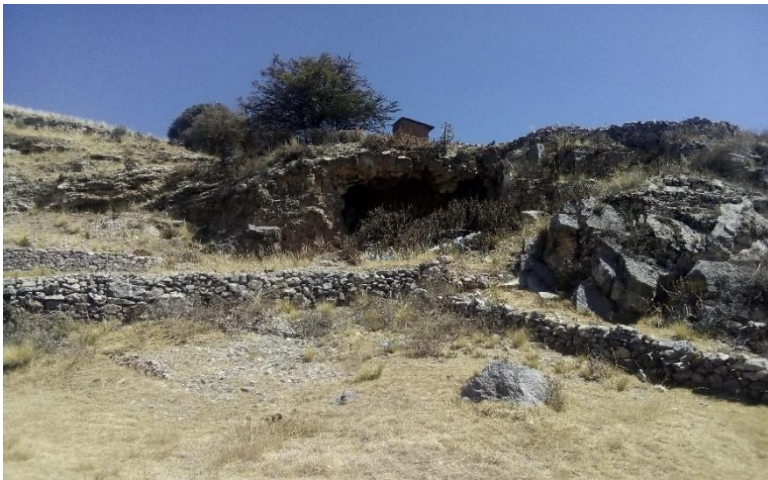
Figura 47. Vista de zona de erosión kárstica generando cavernas y zonas de vacío en el estrato de basamento en coordenadas 393534.21 m E, 8252453.95 m S
