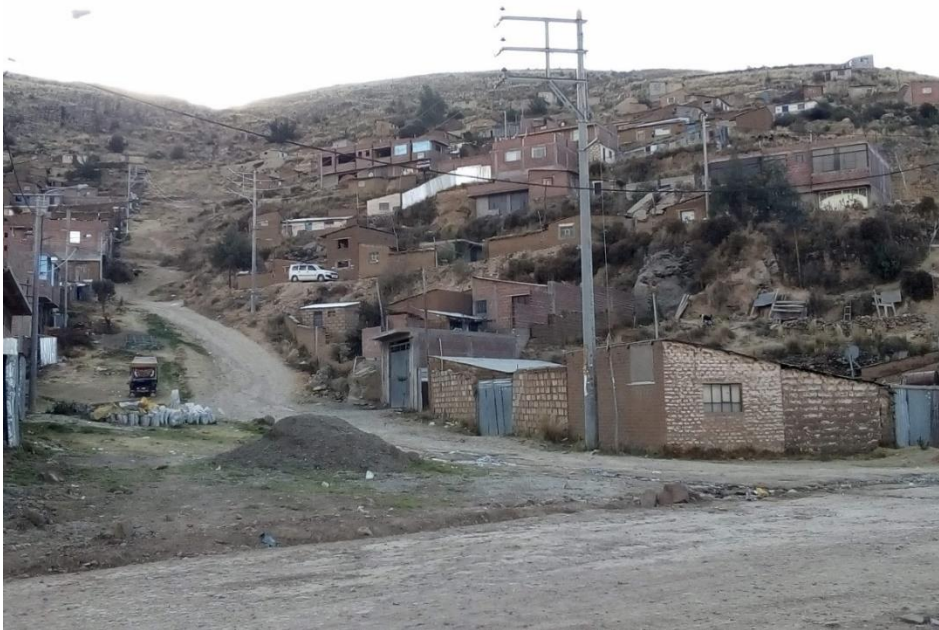
Figura 111. Vista de ladera de pendiente media y zona de depositario de sedimentos originados por precipitaciones pluviales en coordenadas 392614.24 m E, 8245714.72 m S.
