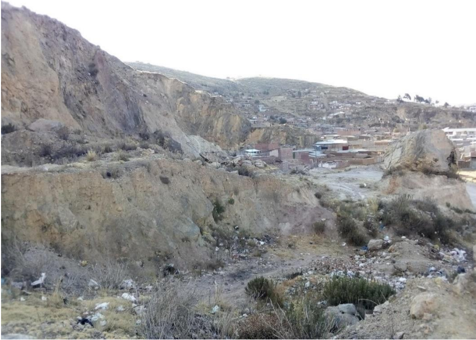
Figura 109. Vista de talud de corte con pendiente alta y asentamiento urbano de la ciudad de Puno en coordenadas 392620.72 m E, 8245422.66 m S
