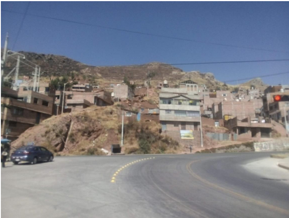
Figura 81. Vista de cima, ladera de pendiente alta de la zona de alto Huáscar, salida a Juliaca en coordenadas 389304.79 m E, 8249844.54 m S
