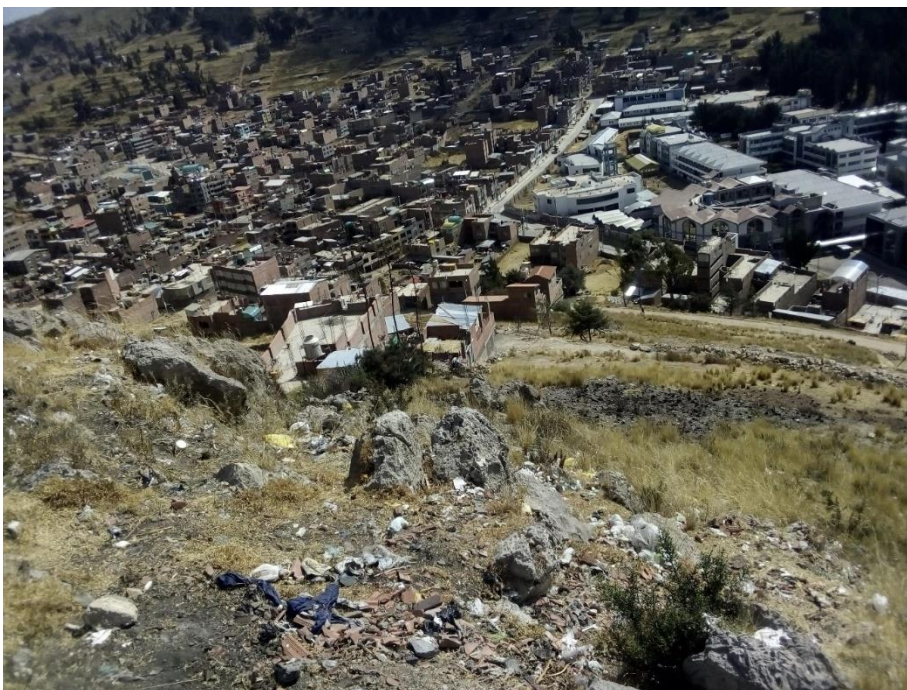
Figura 70. Vista de área urbana susceptible a flujos, desprendimiento de rocas y detritos en coordenadas 390882.61 m E, 8250137.75 m S
