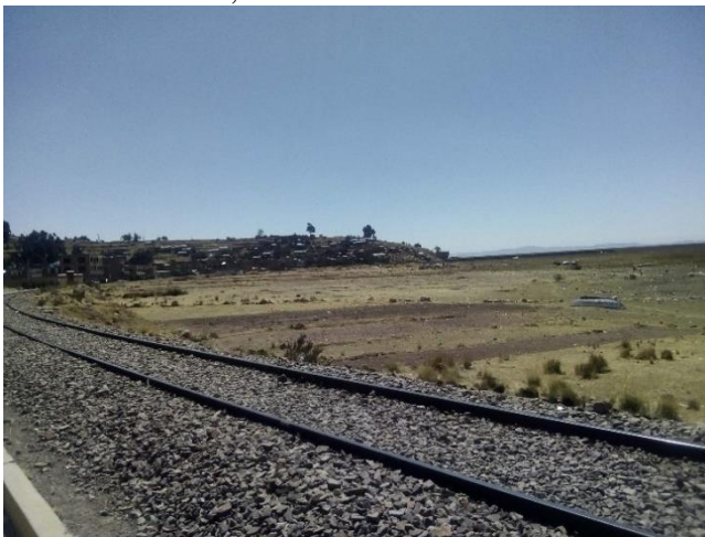
Figura 42. Vista de zona de llanura de inundación en coordenadas 393695.42 m E, 8251442.16 m S
