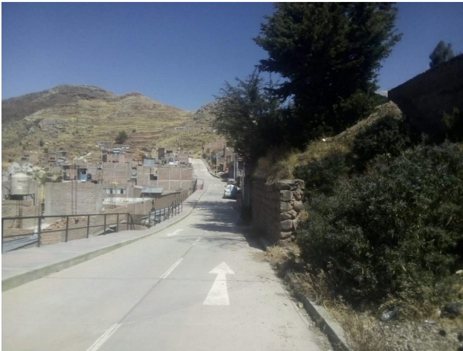
Figura 91. Vista de estabilización de taludes y laderas de pendiente media a alta en zona noreste del área urbana de la ciudad de Puno en coordenadas 389092.85 m E, 8249649.95 m S
