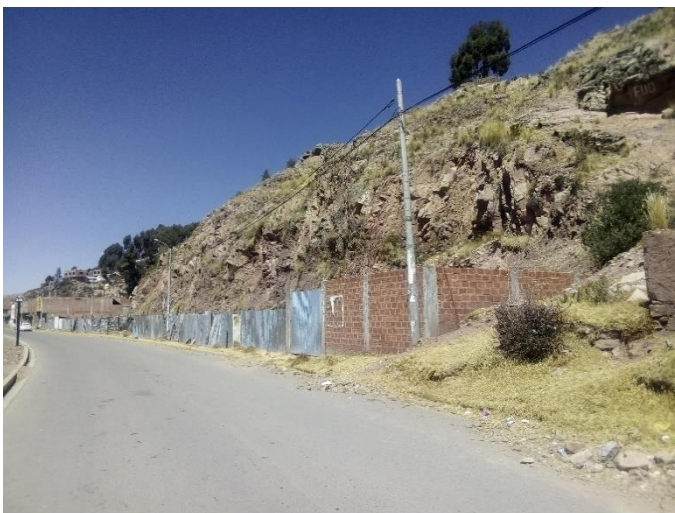
Figura 43. Vista isométrica de zona de talud natural zona de prospección de nueva vivienda en coordenada 393733.76 m E, 8251149.27 m S
