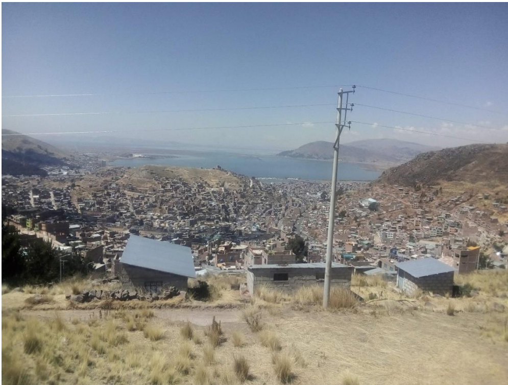
Figura 87. Vista de área urbana de la ciudad de Puno de este a oeste
