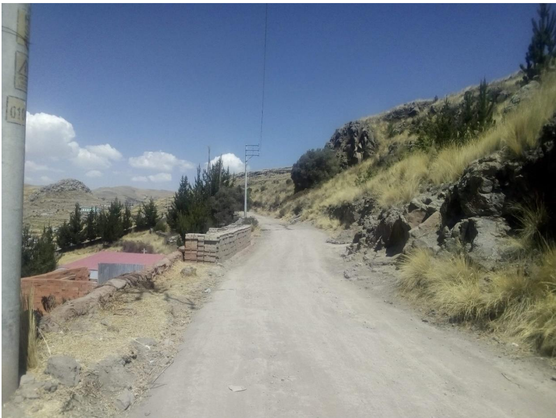
Figura 86. Vista de ladera de pendiente alta y talud natural colíndate a vía de acceso en coordenadas 388975.49 m E, 8249743.33 m S
