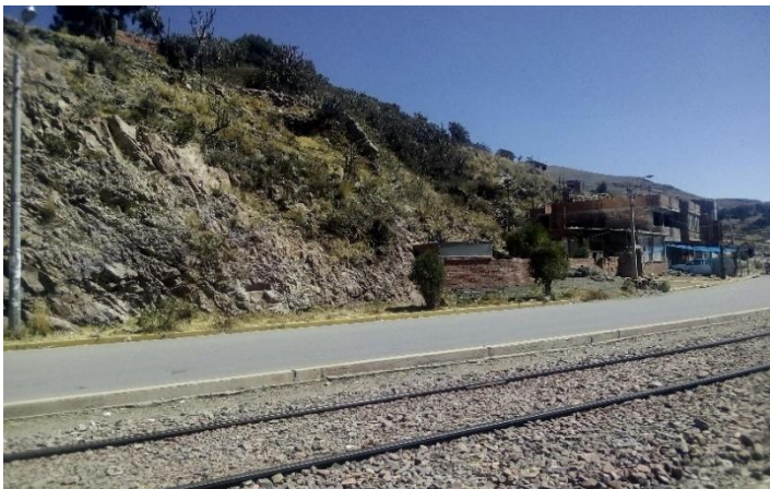
Figura 39. Viviendas colindantes a talud natural en coordenadas 393996.61 m E, 8250877.07 m S
