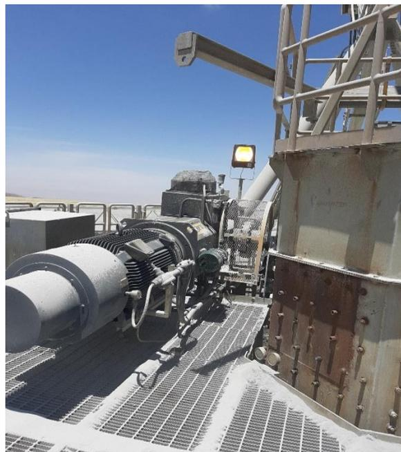
**Figura N° 43:** Motor eléctrico de 4160VAC, instalado en cabeza de faja CV-019.1
