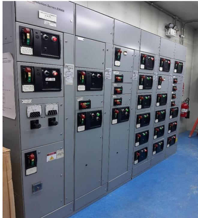
**Figura N° 42:** Centro de control de motores de BT “MCC”.
