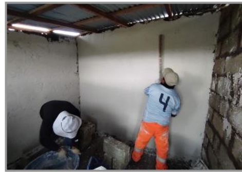
(d) Nivelacion del Enlucido con yeso 09/09/2021
