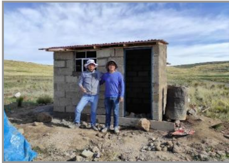
(a) Inicio de Enlucido con yeso 09/09/2021
