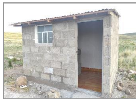
(b) Colocado de vidrio 15/09/2021
