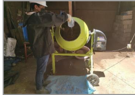
(d) Incorporación de Agua potable 09/06/2021
