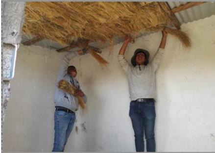
(a) Armado de cielo raso 15/09/2021
