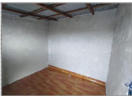
(a) Colocado de piso 15/09/2021
