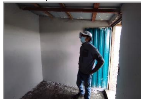
(f) Enlucido termiando con yeso 10/09/2021
