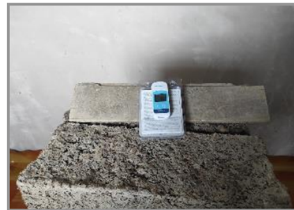
(b) Colocado de sensor 15/09/2021
