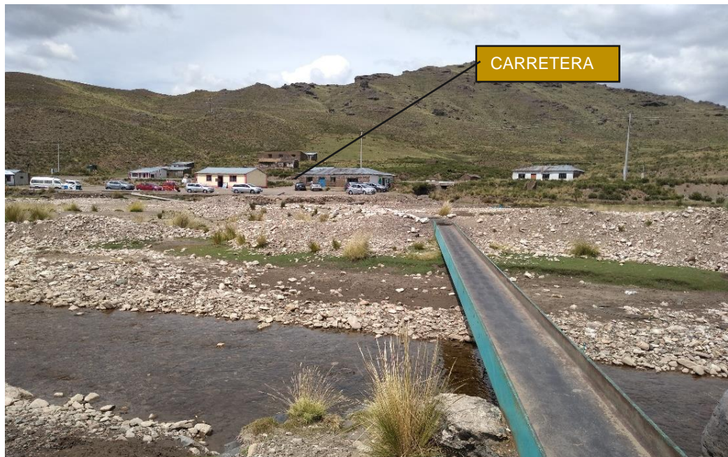
Figura 72: Ingreso de la carretera Interoceánica Sur al balneario termal.
