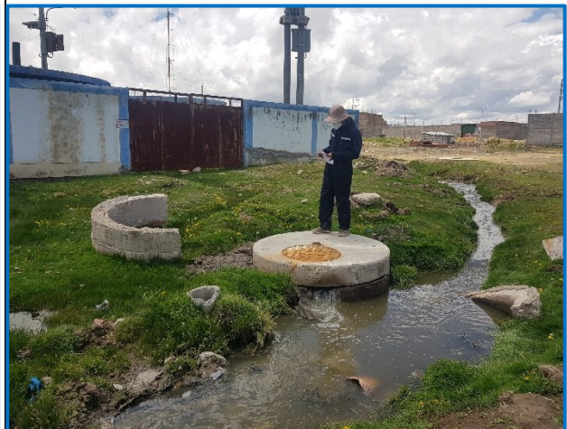
VISTA POR DENTRO DE BUZÓN Bz:043
