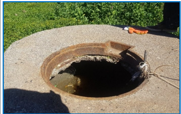
VISTA POR DENTRO DE BUZÓN Bz:044
