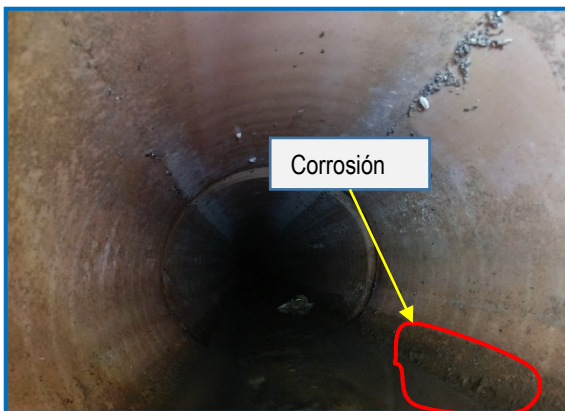
VISTA POR DENTRO DE TUBERÍA DE PVC: N°01
