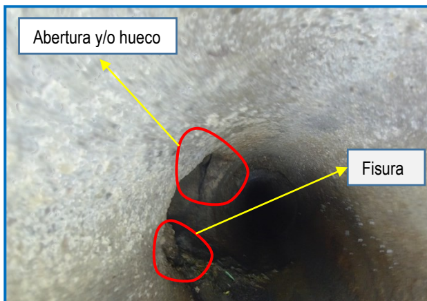
VISTA POR DENTRO DE TUBERÍA DE CSN: N°01
