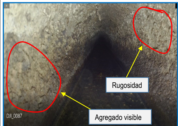
VISTA POR DENTRO DE TUBERÍA DE CSN: N°02
