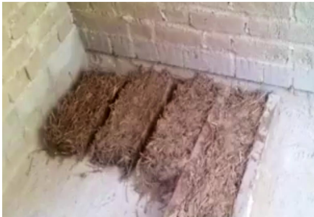
Figura 67. Encofrado y secado de los fardos de paja comprimida.
