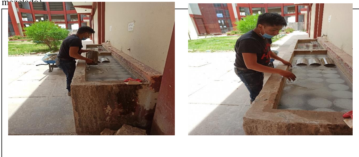
Foto N° 18, curado del concreto ( izq. y der. )
