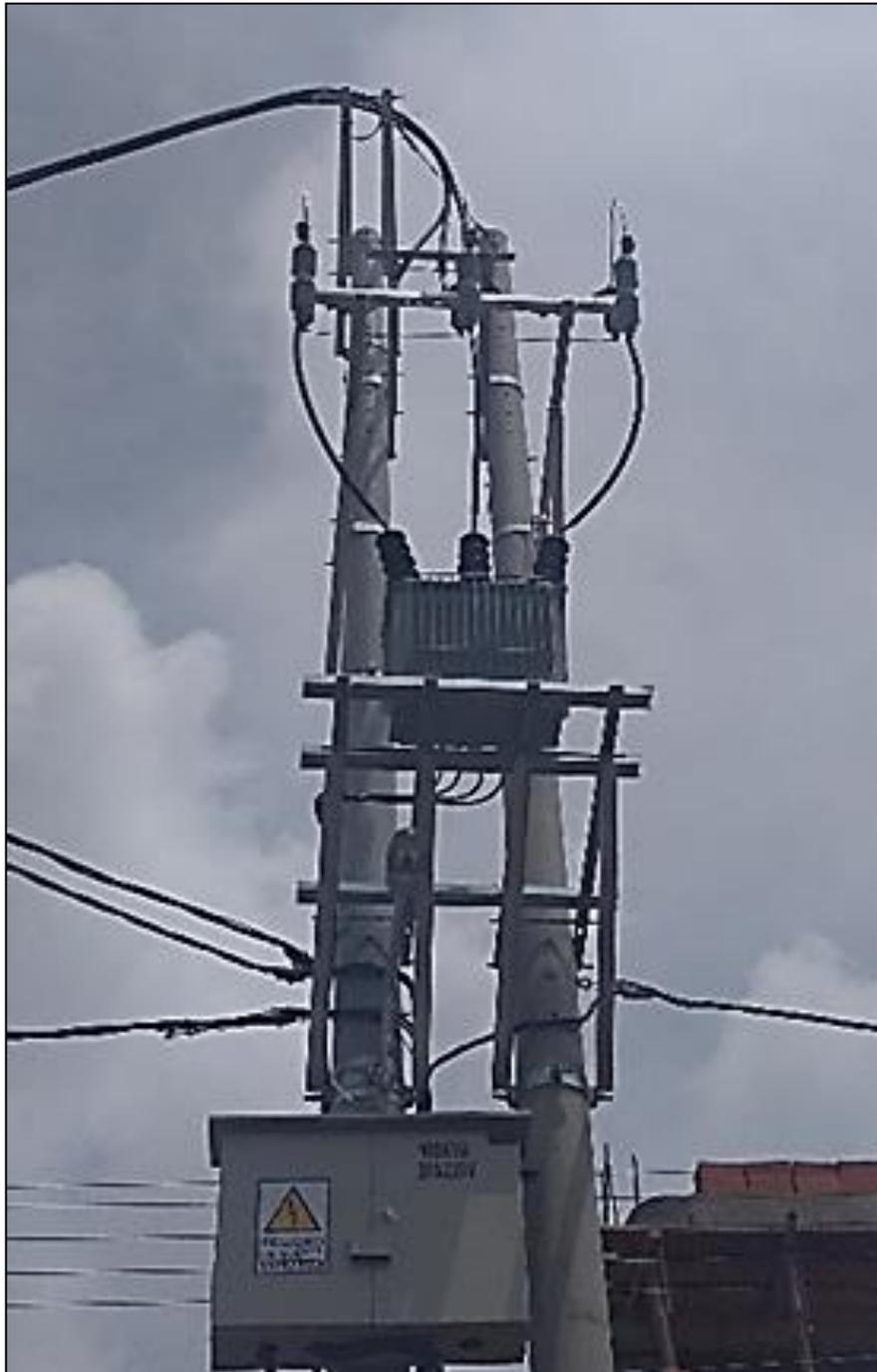
*Figura 17.* Sub Estación de Distribución en media tensión (Acora)
