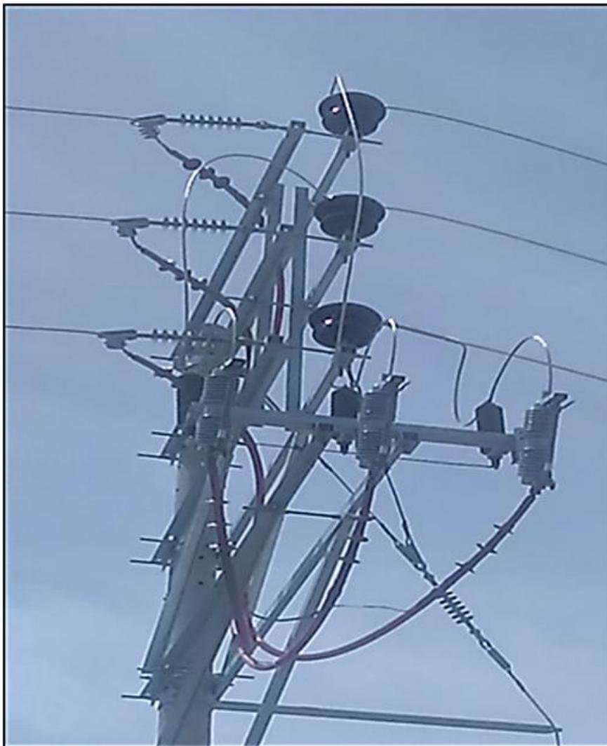
Figura 14. Sistema Pararrayos, seccionador- fusible (Tramo Acora)
