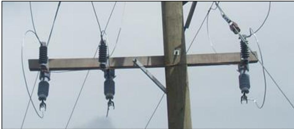
Figura 15. Conjunto Pararrayos, seccionador- fusible
