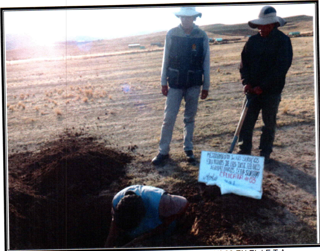
EN LA FOTO SE OBSERVA REALIZANDO LA CALICATA N° 03 EN EL I.E.T.A. SORAPA DISTRITO DE JULI PROVINCIA DE CHUCUITO JULI - PUNO.
