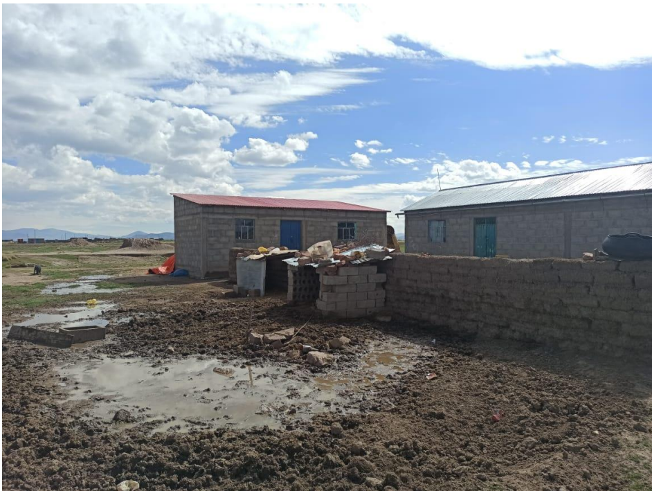
Figura 17. “Hogar de los chanchos”, construida con materiales: Ladrillo sillar y calamina, podemos observar barro, debido a las lluvias del día anterior, Fuente L. Blanco (2021).
