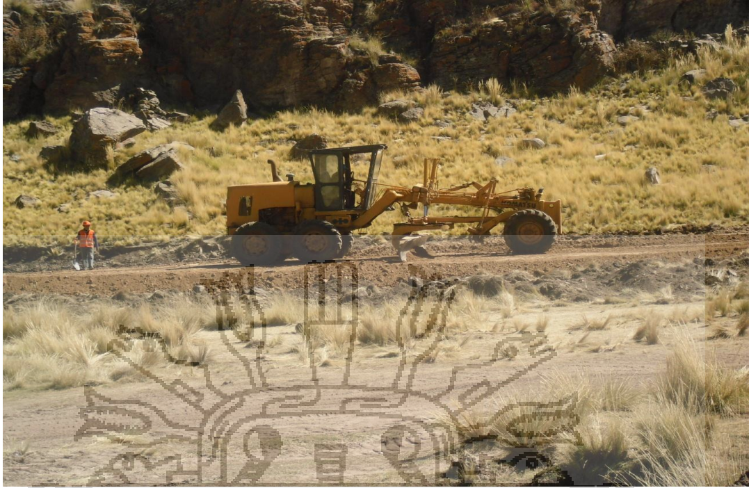
FOTO N° 07, EXPLANACION DE MATERIAL DE RELLENO CON MOTONIVELADORA A NIVEL DE PLATAFORMA
