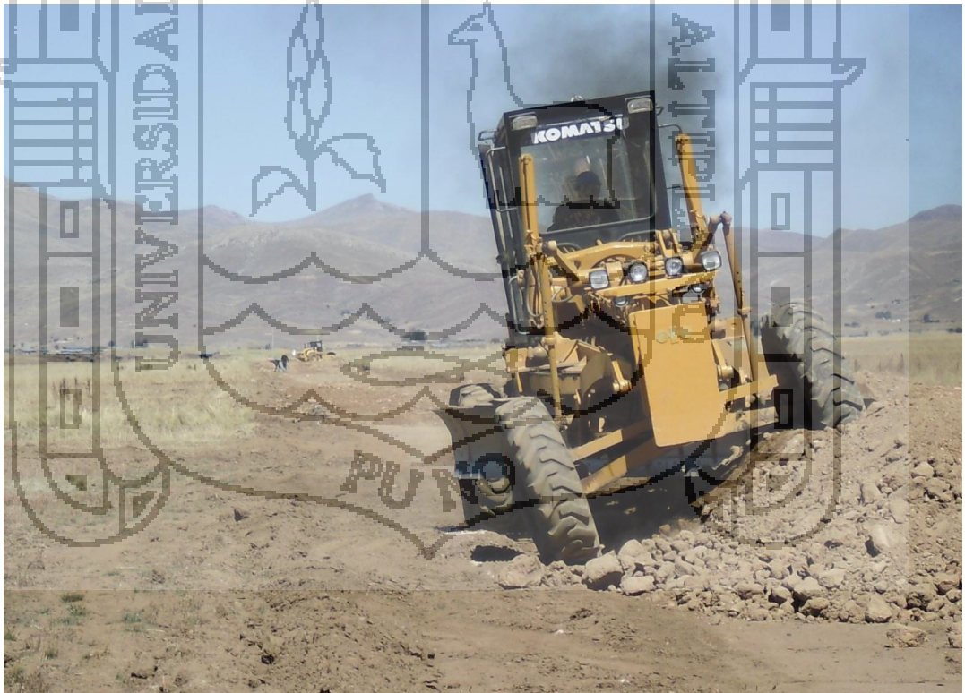
FOTO N° 08, DESBROCE DE TERRENO NATURAL, PARA PREPARACION DE PRIMERA CAPA DE TERRAPLEN
