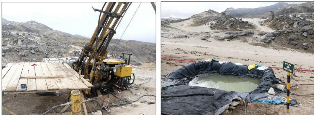
Figura 16. Plataformas de perforación y su poza de lodos.
