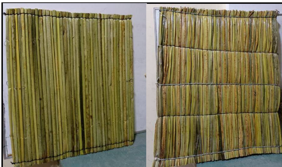
Fotografía 06. PANELES DE TOTORA DE TEJIDO HICALINA E HILADAS
