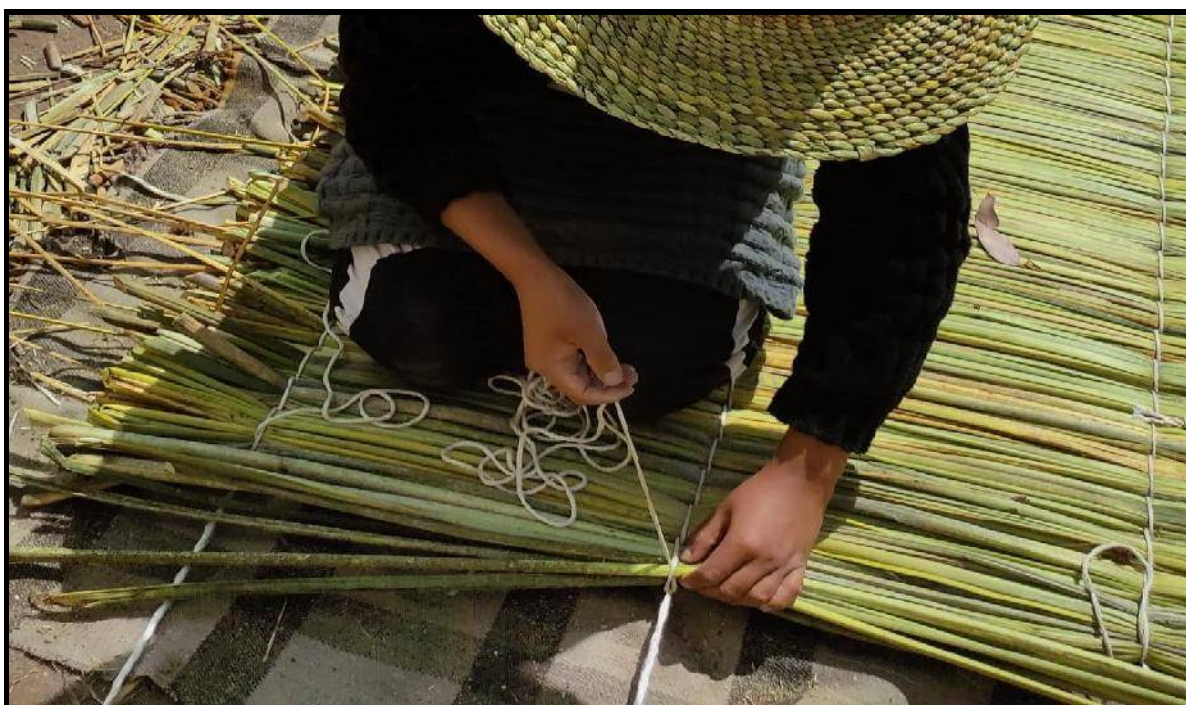
Fotografía 04. PROCESO DE TEJIDO DE LOS PANELES DE TOTORA
