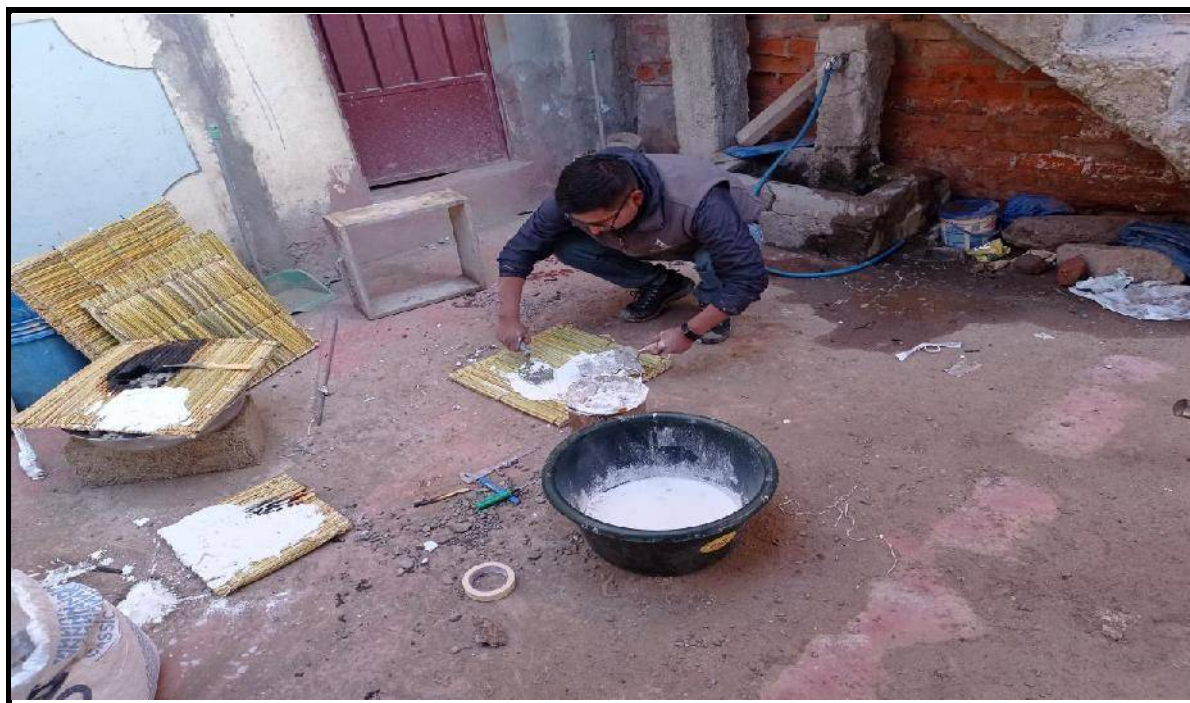
Fotografía 12. REVESTIMIENTO A LOS PANELES DE TOTORA CON YESO
