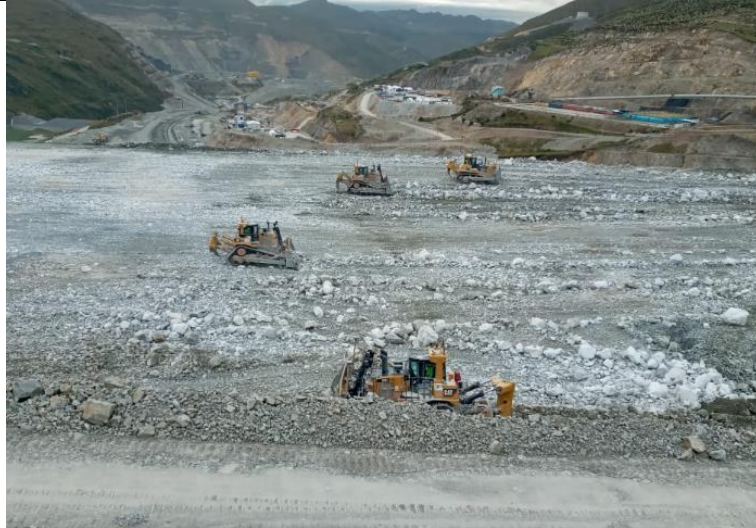
6. Tren de Trabajo en Ferrobamba Norte – Material Tipo 2
