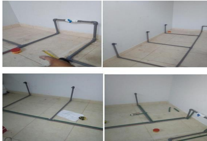
Figura 2. Instalación de tuberías de polietileno
