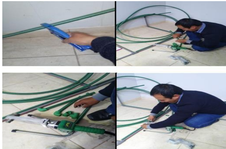
Figura 3. Instalación de tuberías de polietileno
