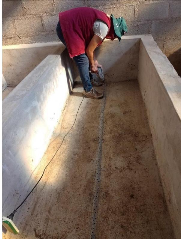
**Figura 38.** Incorporación de agujeros 5 mm de diámetro a las camas de vermicompost
