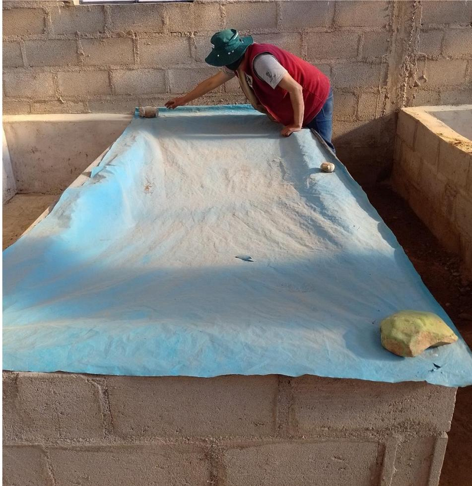
**Figura 50.** Tapado de la cama de vermicompost con un plástica
