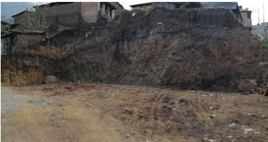
Foto 6. Construcción de viviendas sobre suelos por encima del nivel freático
