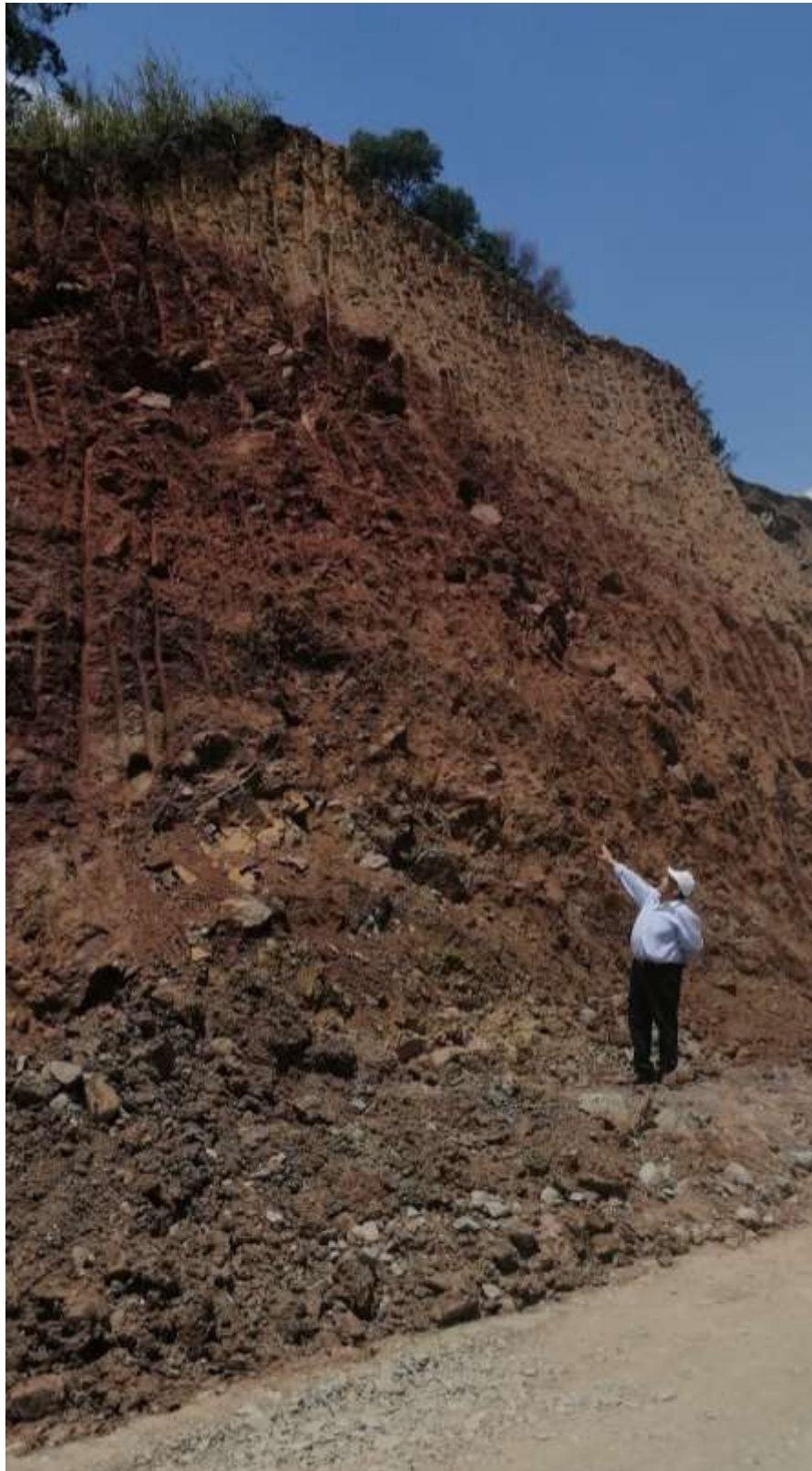
Foto 1. Corte de talud de carretera de evitamiento, muestra el tipo de suelo limo arcilloso (zona norte de Bellavista)
