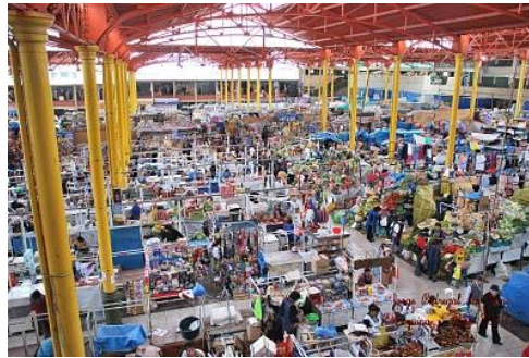
Figura N° 28. Del Interior del Mercado la Estructuras Metálicas – Tijerales.
