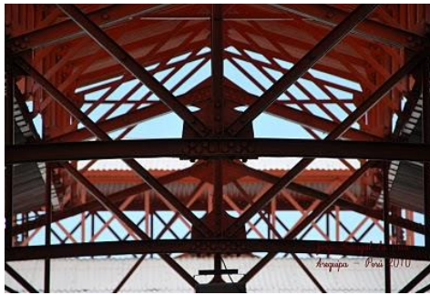
Figura N° 31. Del interior del Mercado la Estructura – Tijerales y Uniones.
