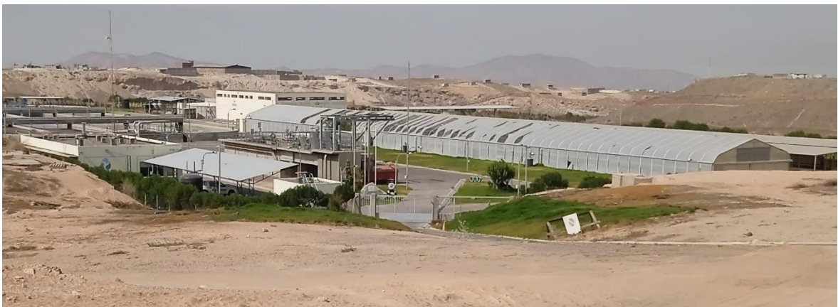
Planta de tratamiento de aguas residuales Escalerilla.
